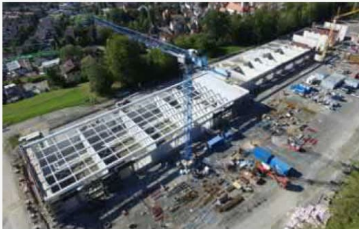
Neubau Technischer Ausbildungsbereich GOB Sonthofen
