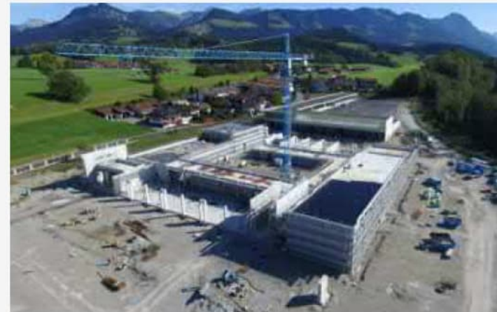
Neubau Technischer Bereich GOB Sonthofen
