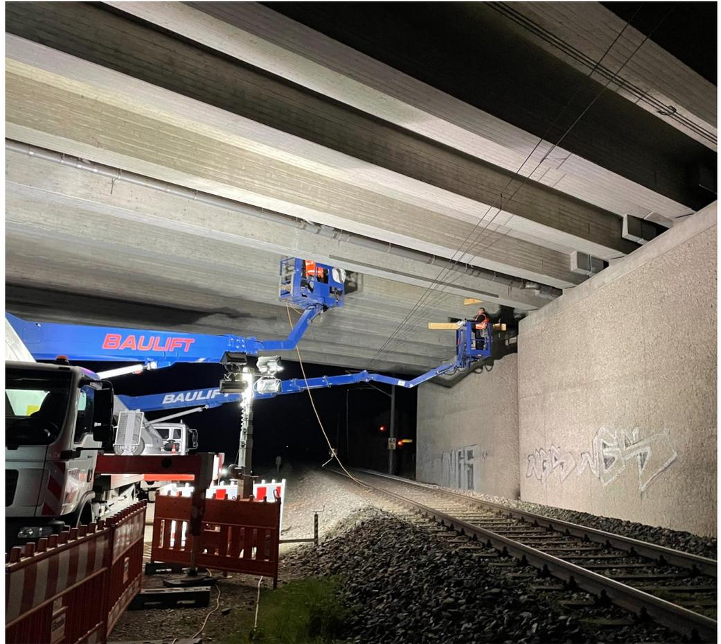
Einbau des Kappengerüsts im Bereich der Bahnlinie in Nachtschichten
