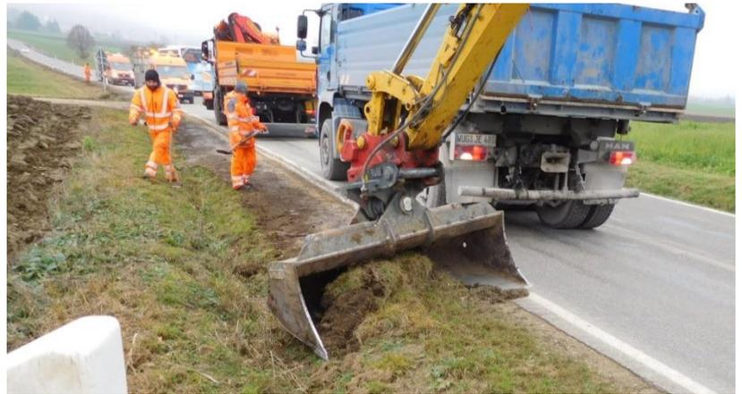
Schälen des Banketts zur Gewährleistung eines guten Abflusses des Niederschlagswassers
