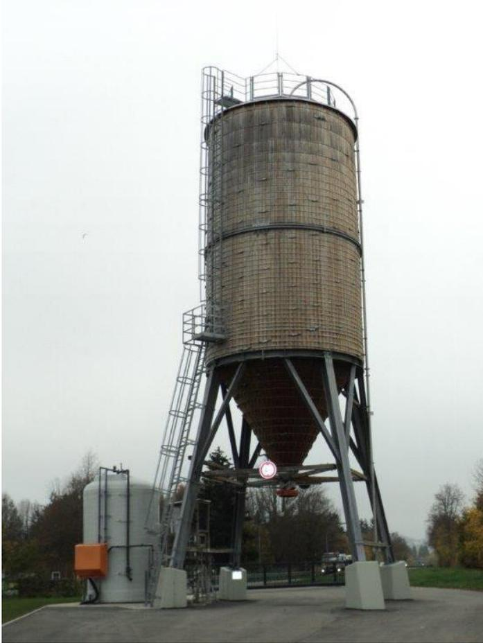
Bau eines Lagerplatzes mit Soletank und Salzsilo bei Oettingen
