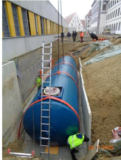
Erdtank mit Auftriebsicherung
