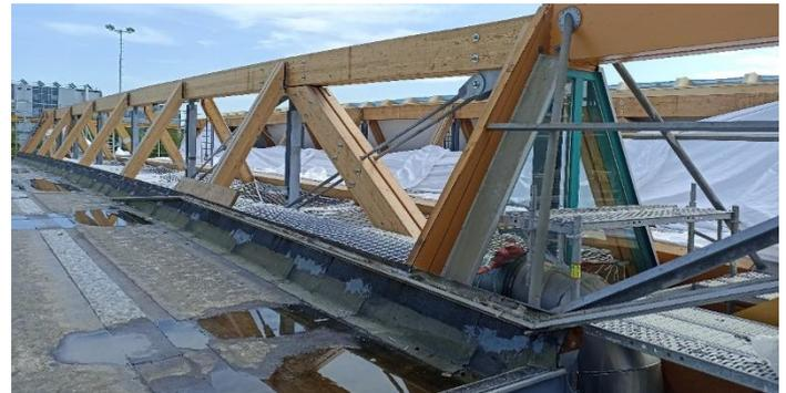
Dach nach Rückbau von Kies, Dämmung und Doppelsteplatten
