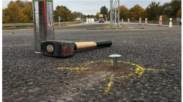
Stationsnagel zur Markierung der Station auf der Fahrbahn
