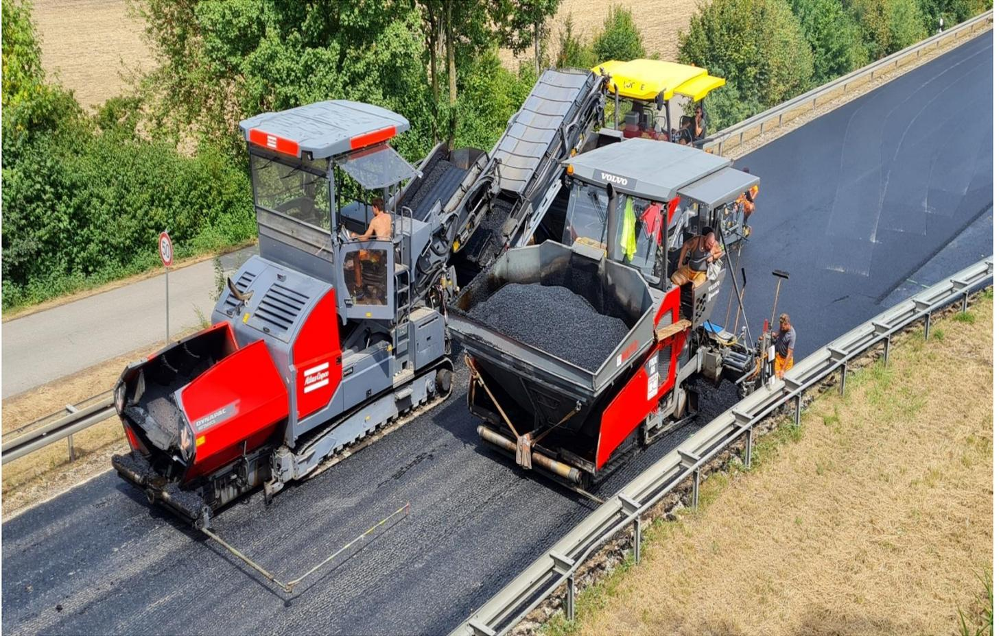
Einbau der Fahrbahndeckschicht mit Beschicker und zwei Fertignern
