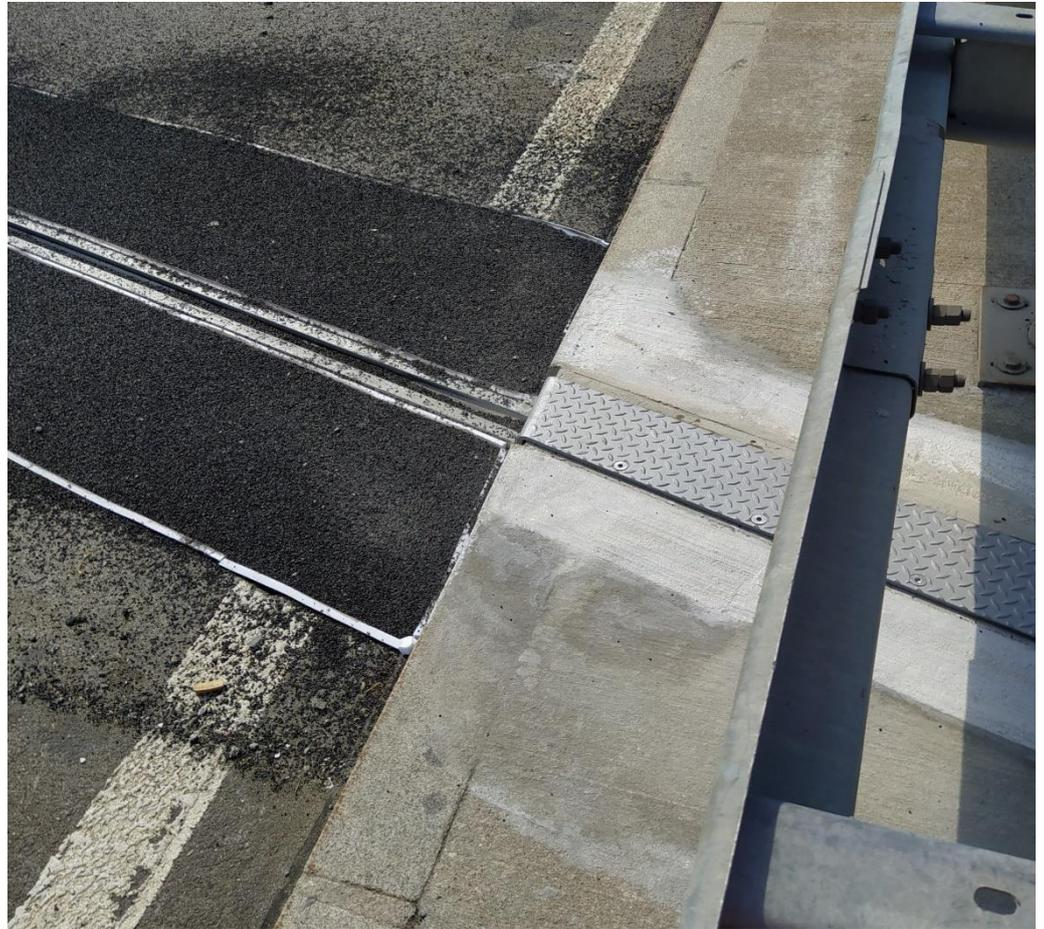
Umgebaute Übergangskonstruktion nach dem Einbau des Gussasphaltes
