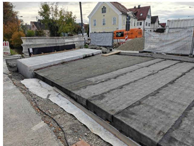
Abdichtung des Überbaus mit Bitumenschweißbahnen
