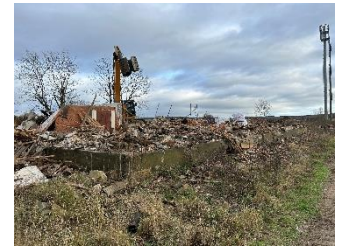
JVA Kaisheim – Gut Neuhof Abbruch Stall 12
