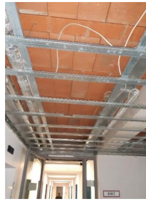
Flur, abgehängte Decke
