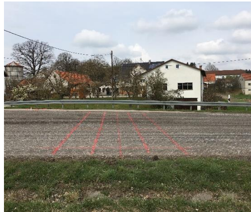
Neuinstallation der Dauerzählstelle auf der B 300 bei Oberzell
