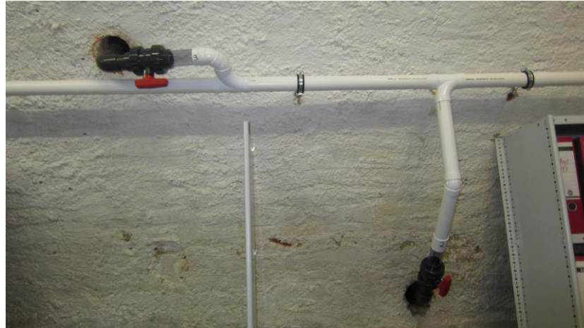
Radon Absaugung
