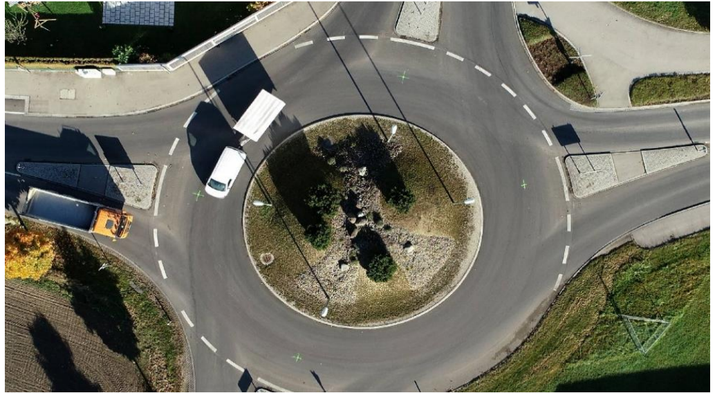
Einmessen der Nullpunkte nach Deckenbau am Kreisverkehr
