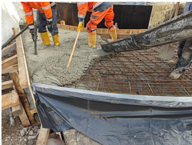
Beginn der Betonage einer Kappe
