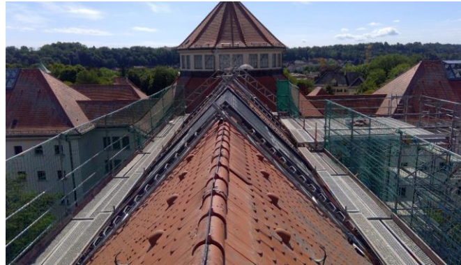
Arbeitsgerüst auf dem Dach des Zellenflügel C
