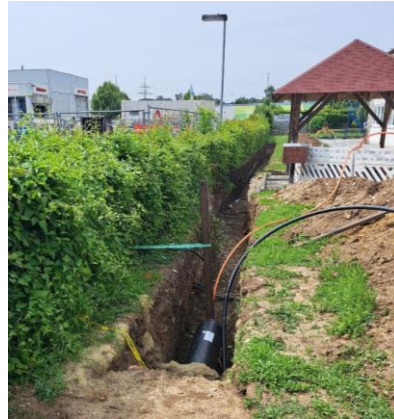
Verlegung der Fernwärmeleitung
