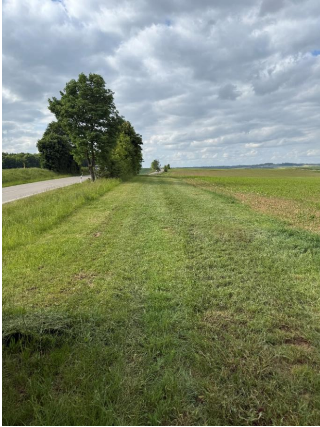
Geh- und Radweg vor bzw. während der Bauarbeiten
