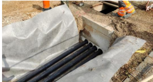
Leerrohre Stromversorgung
