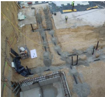
KG 410 Neubau Grundleitung
