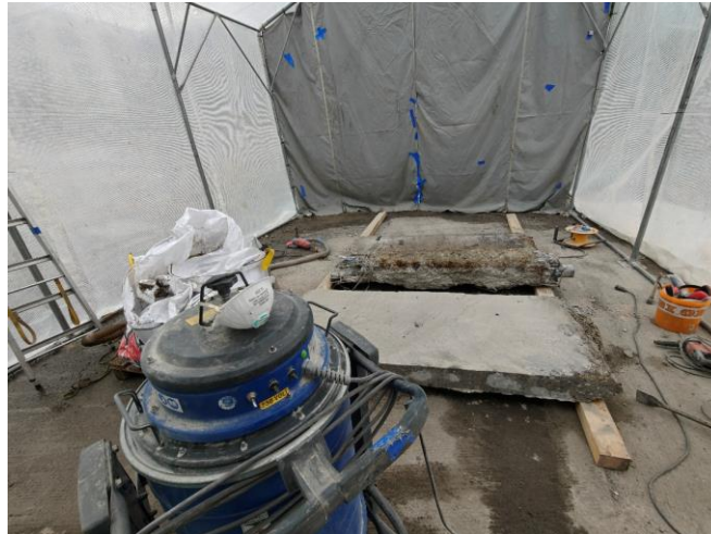
Asbestseparierung unter Schutzzelt
