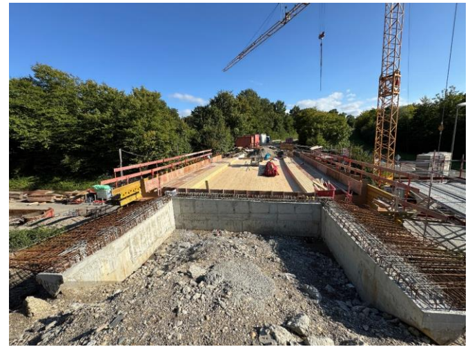
Schalung des Überbaues
