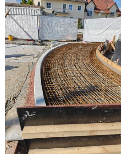
Bewehrung der Kappe
