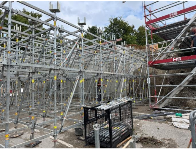
Traggerüst für die Schalung des Überbaues
