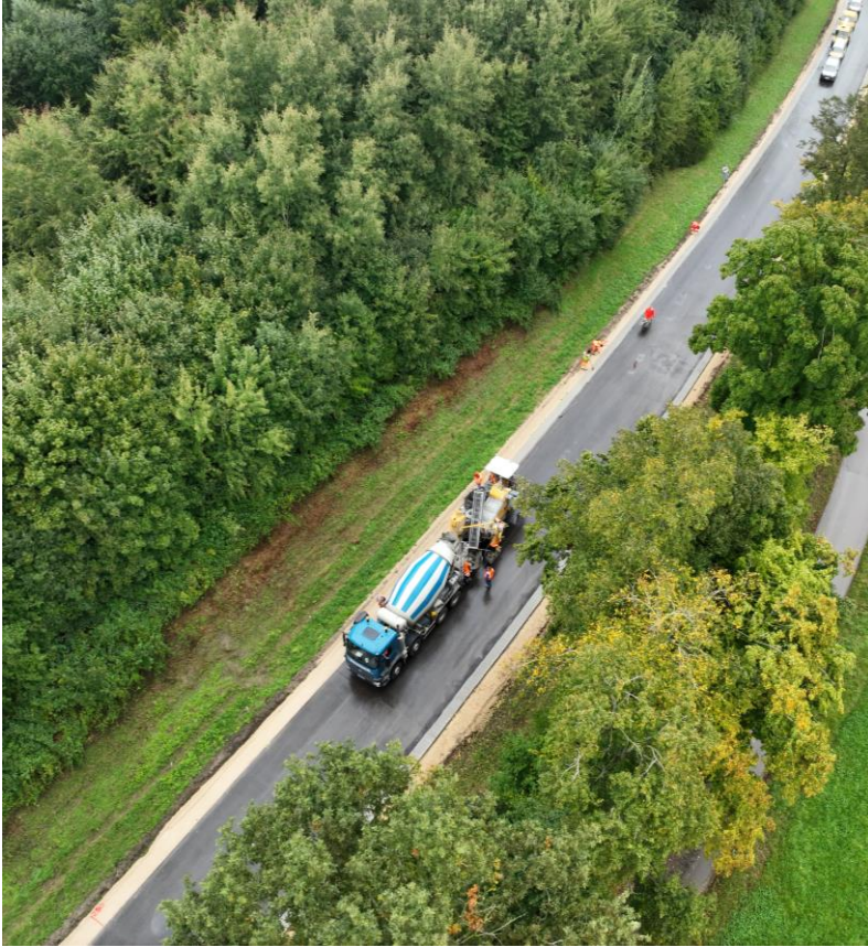
Einbau des Banketts
