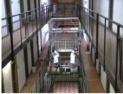
Laser-Entsichtung der Stahlgeländer zur Brandschutzbeschichtung
