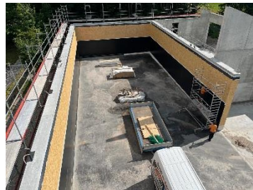
Innenwandverkleidung Salzlager
