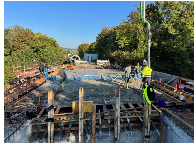
Betonage des Überbaues
