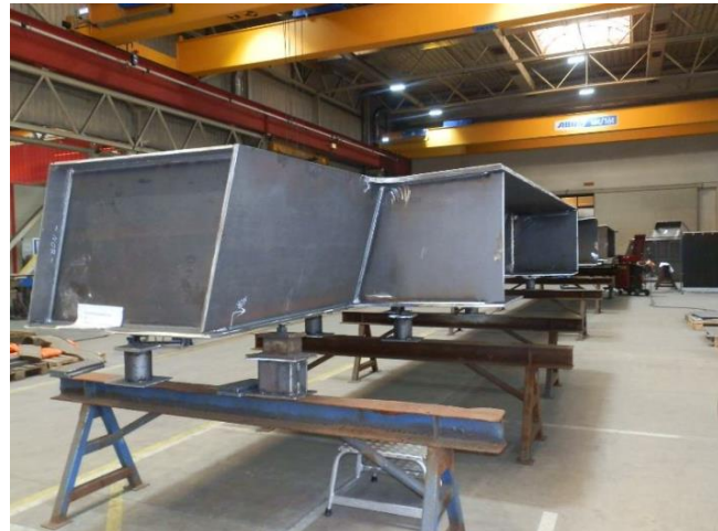
Überwachung der Herstellung der Stahlbauteile im Werk
