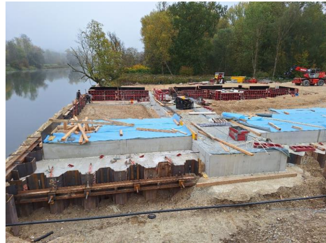
Schalarbeiten an der Verschubbahn
