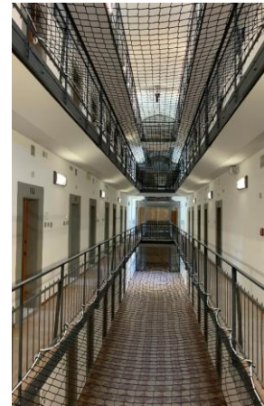
Blick in den sanierten ZF C
