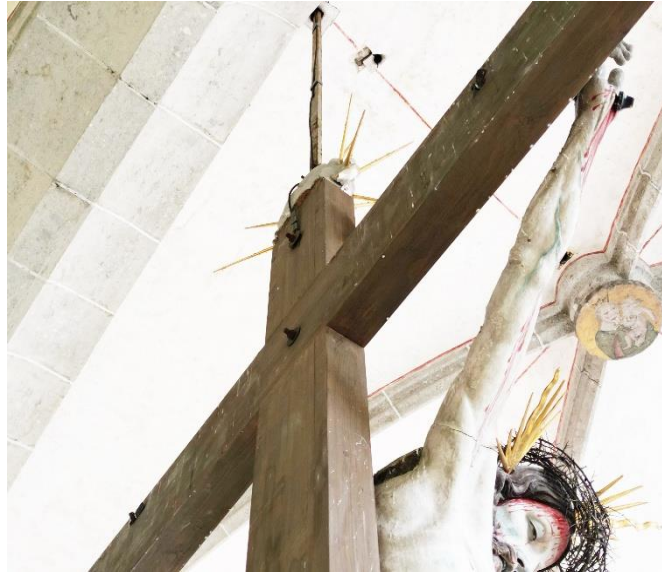
Kirche Kaisheim Erneuerung Kreuzaufhängung
