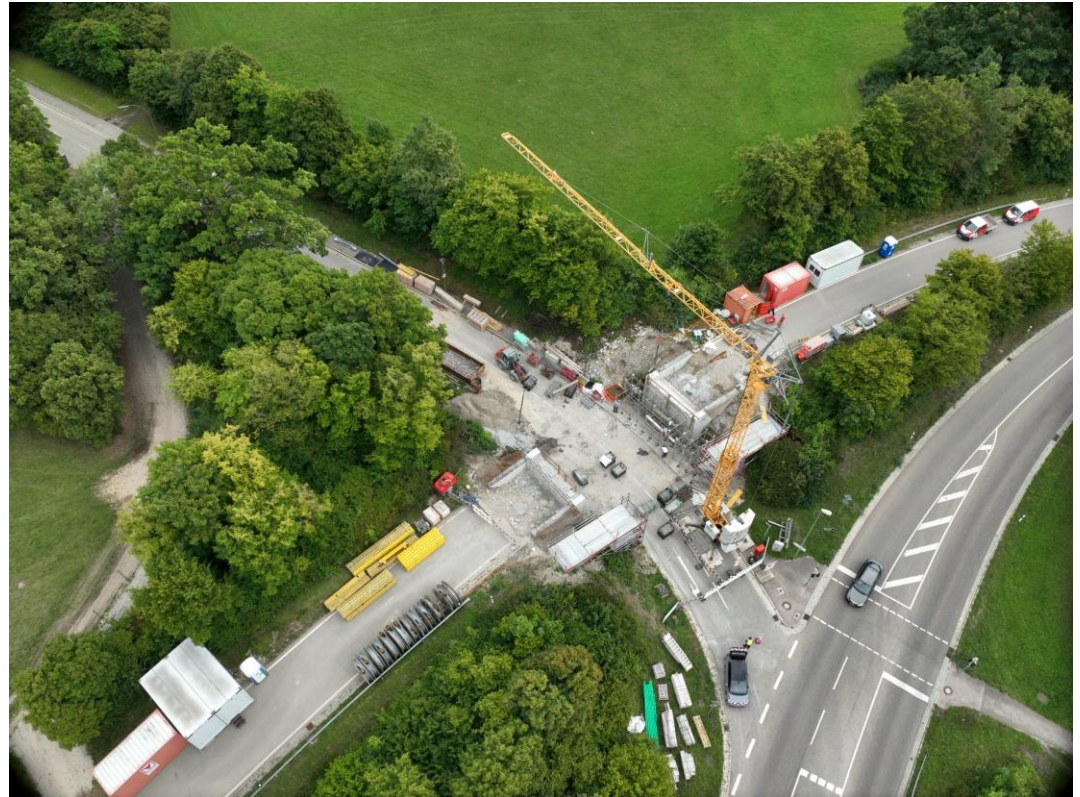
Beginn der Traggerüstarbeiten für die Schalung des Überbaues
