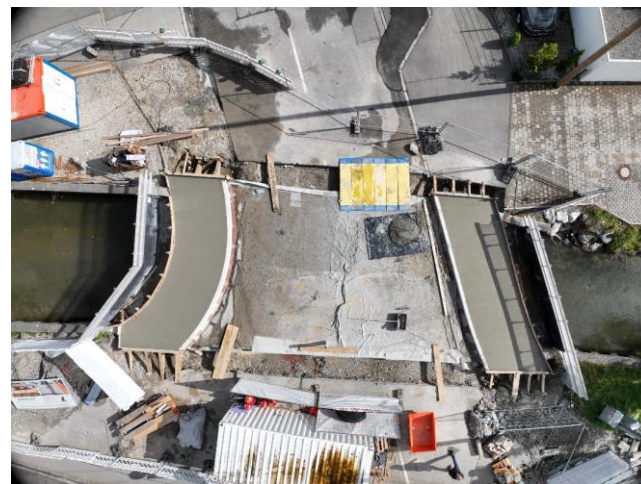
Fertiggestellte Kappen auf der Singoldbrücke
