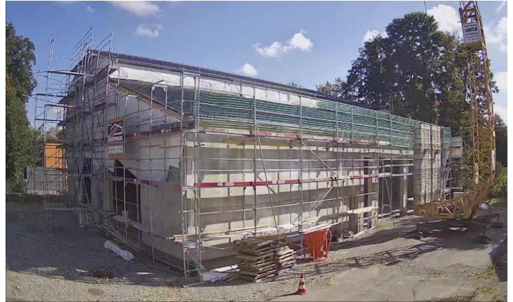
Montagearbeiten transluzente Fassade
