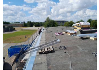
Instandsetzung Dachrinne
