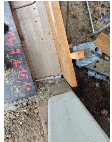
Kappenschalung mit Verankerung in den Überbau
