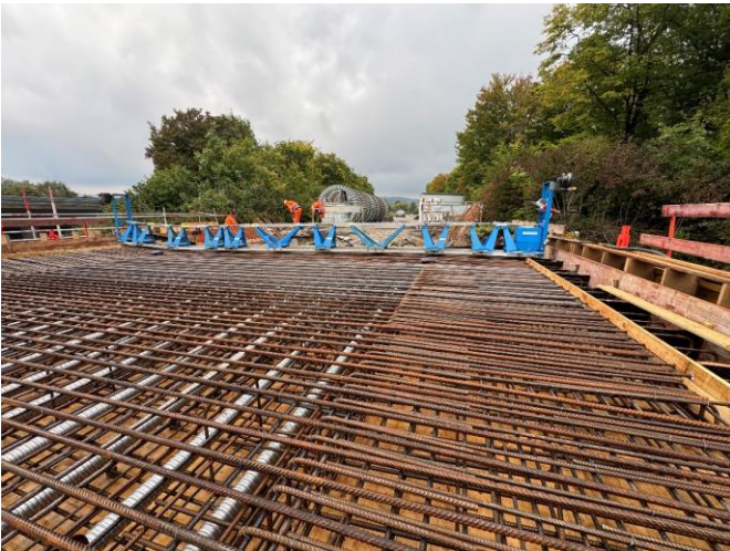
Bewehrung des Überbaues mit Hüllrohren für die Spannglieder
