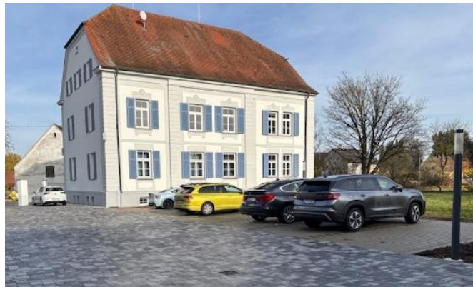
JVA Niederschönenfeld – SeKo+ZeVe Neugestaltung Hof und Außenanlagen
