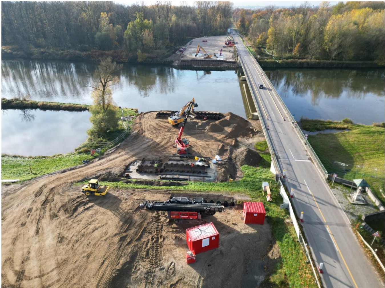
Baufeld am 31.10.2025 mit Montagefläche für die Netzwerkbogenbrücke (hinten im Bild) und Gründungen in drei Achsen für die provisorischen Unterbauten
