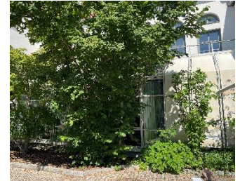
AG Nördlingen Erneuerung Sonnenschutz Süden
