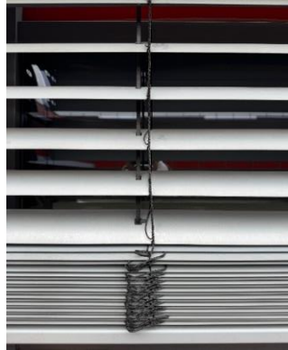
Reparatur Sonnenschutzkonsole Geb. H
