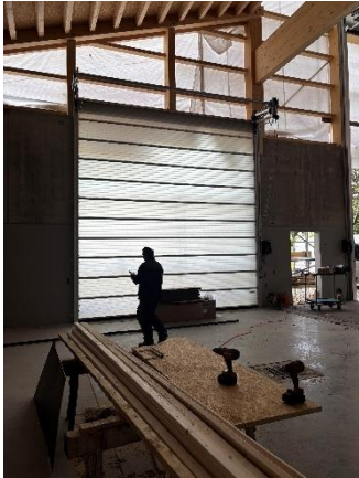
Einbau Hubstaffeltor
