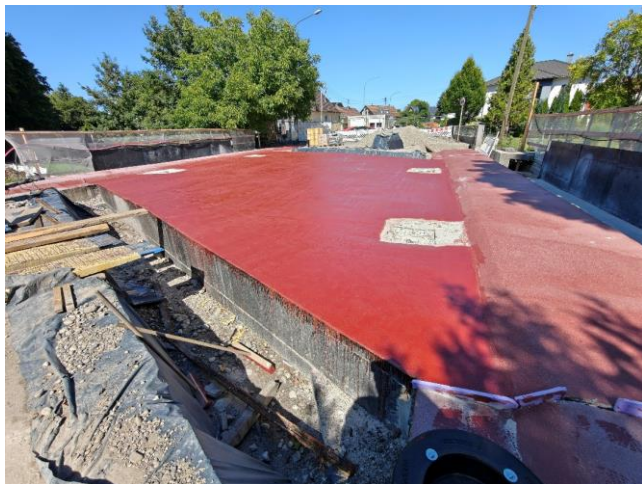
Versiegelung der Betonoberfläche mit Epoxidharz auf dem Überbau
