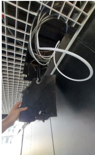
Dämmungstausch Geb. KLM
