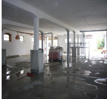
JVA Kaisheim – Gut Neuhof Einbau Garage Gebäude 11
