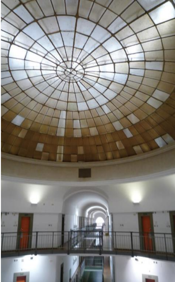
Zentralbau Kuppelverglasung
