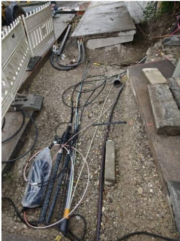
Versorgungsleitungen im Bereich der Brücke
