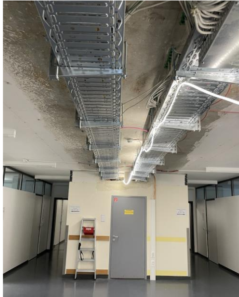
1 km Kabelrinne wurde neu verlegt.
