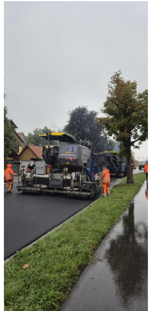
Einbau Deckschicht
