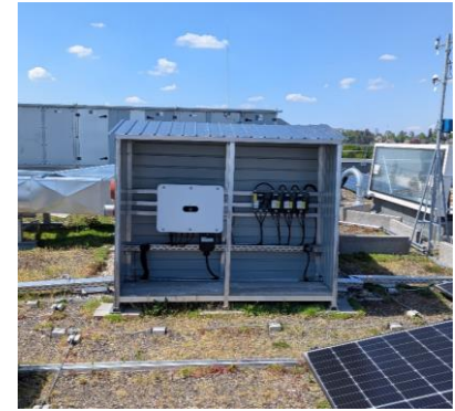
Wechselrichter
