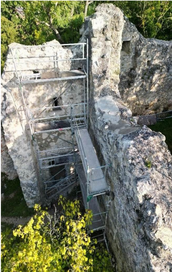
Ruine Niederhaus Laufende Erhaltungsmaßnahmen
