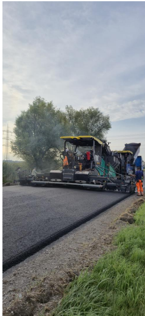
Einbau Binderschicht
