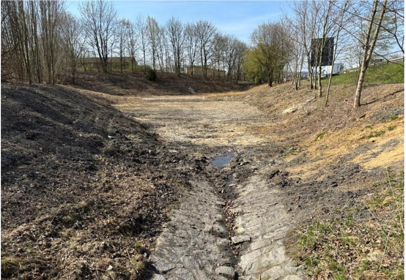
Technische Bauwerke wie dieses Sickerbecken werden regelmäßig von Bewuchs befreit, um die Funktionsfähigkeit zu gewährleisten.
