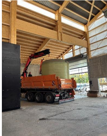
Einbau Solebehälter
