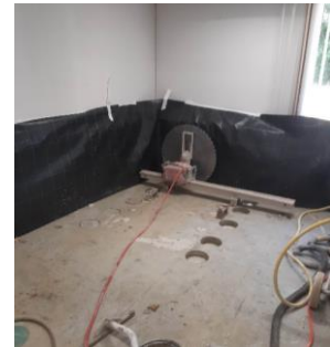
Einbringschacht für Fernwärme
