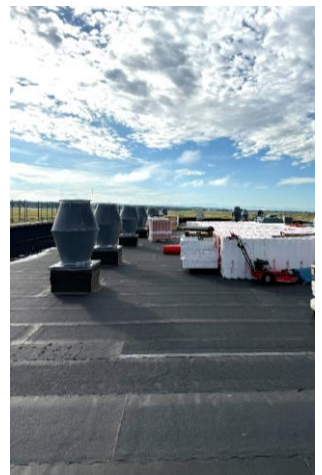
Instandsetzung Dach und Fassade
