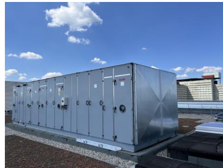
Laborlüftung Abluft-Gerät
