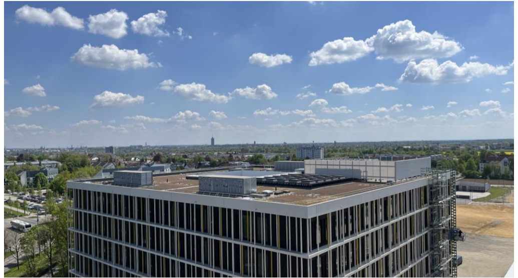
Blick vom LGB auf die Dachzentralen des ITM
