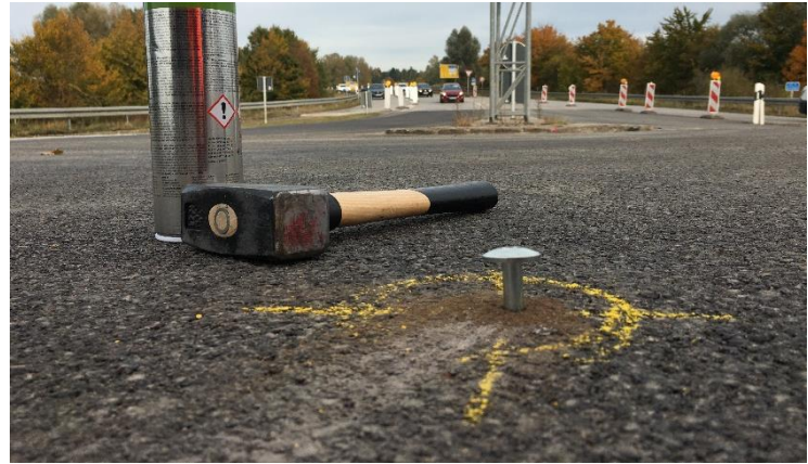
Stationsnagel zur Markierung der Station auf der Fahrbahn
