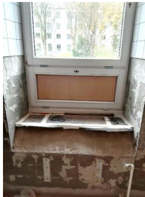
Umbau Fenster innen
