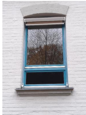
Umbau Fenster außen
