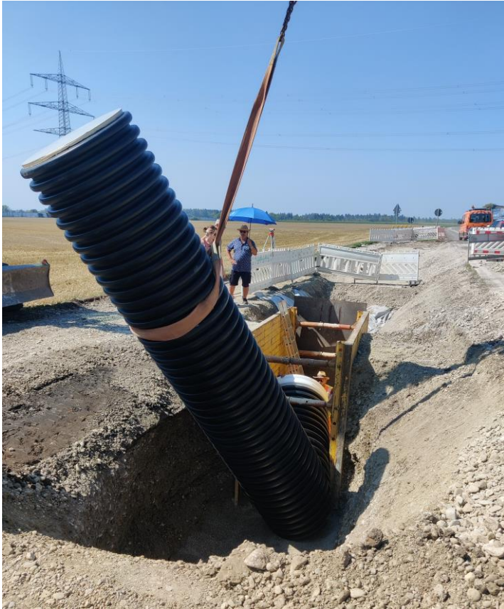
Anlieferung und Einbau einer Sedimentationsanlage
