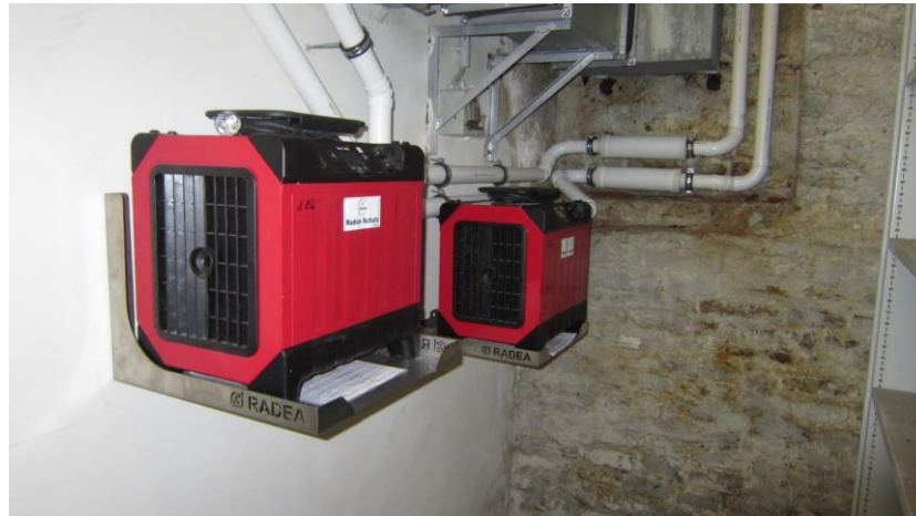
Zentralgeräte Radonabsaugung
