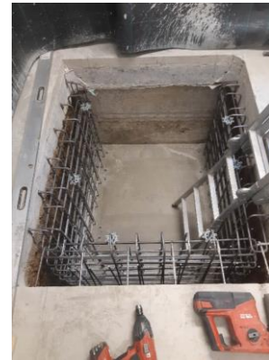
Einbringschacht für Fernwärme
