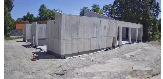
Stahlbetonwände
