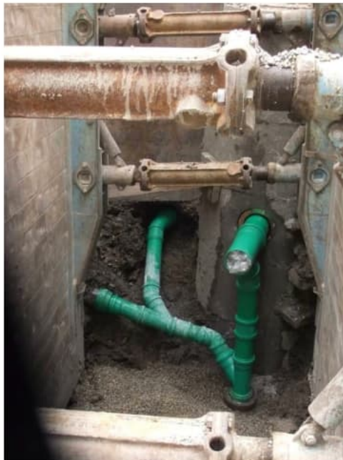
Rohrleitungszusammenschluß
