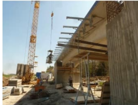
Einbau Kappengerüst
