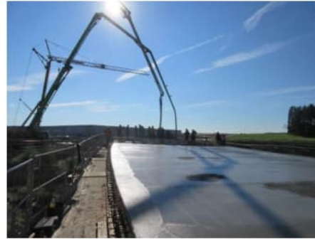
Betonage des Überbaues am Bauwerk 202
