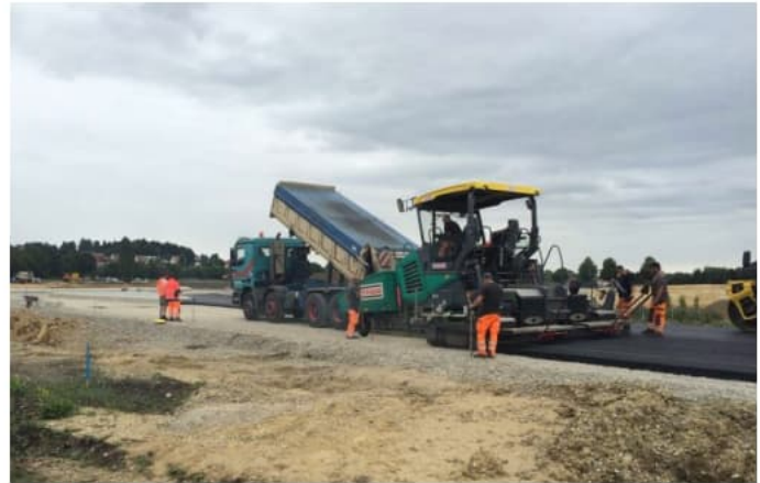
Einbau der Tragschicht
