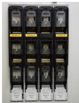
Die neuen Lasttrennschalter sind gegen Berührung gesichert
