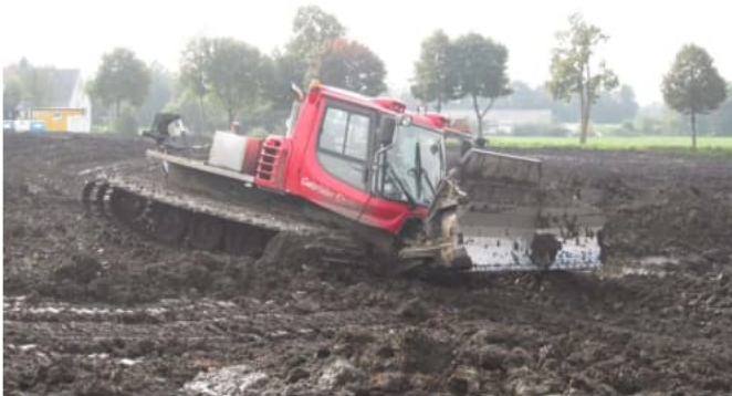
Einbau des Torfmaterials für eine Geländeanhebung mit Pistenraupen in 2014
