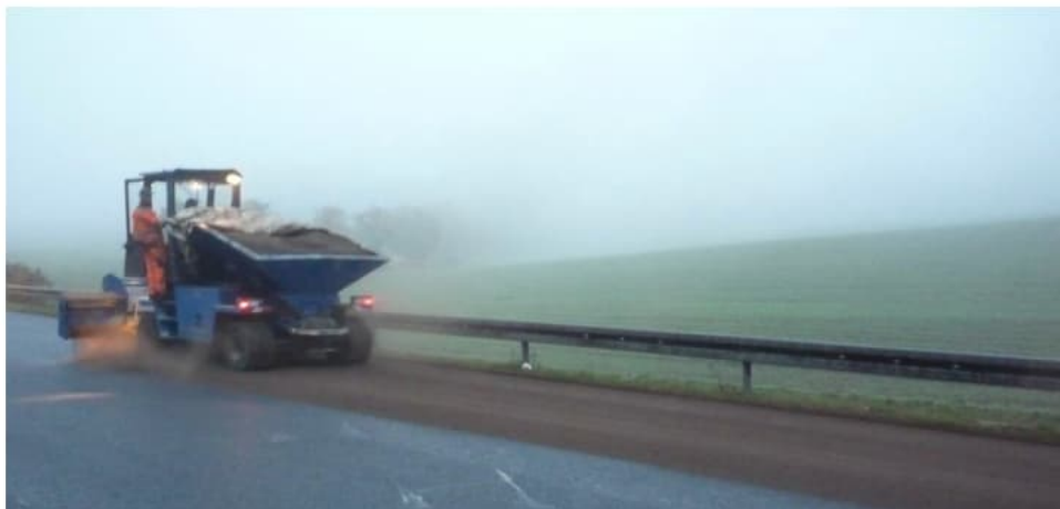
Abstreuen der Asphaltdecke
