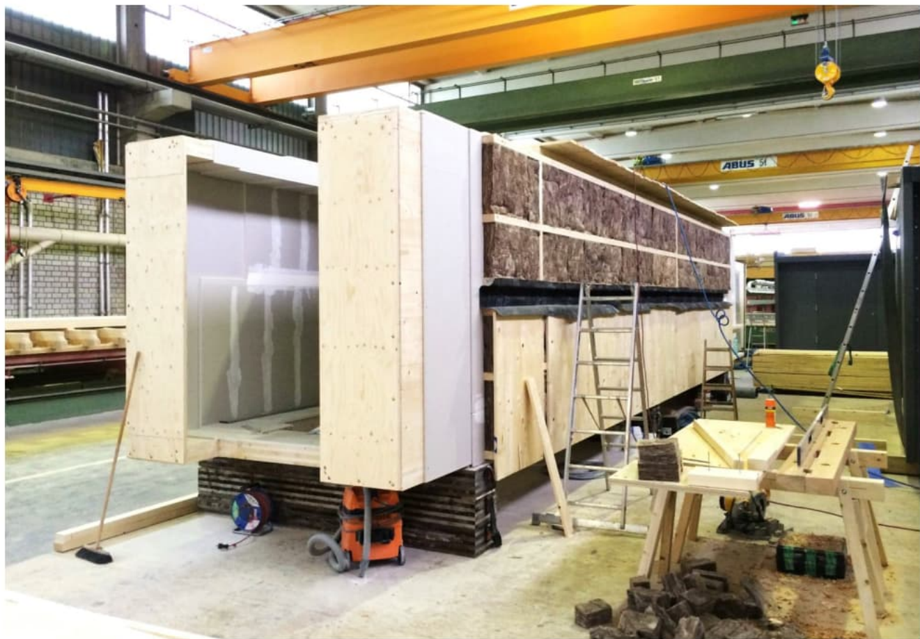
Vorfertigung Aufzugsschacht im Werk
