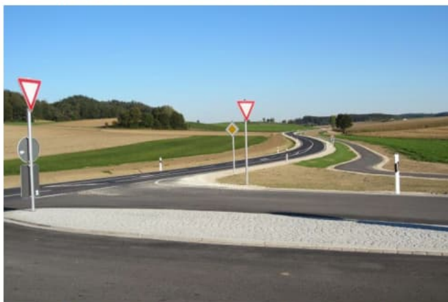
Fertiggestellte Straße mit Fahrbahnmarkierung, Beschilderung und Leitpfosten
