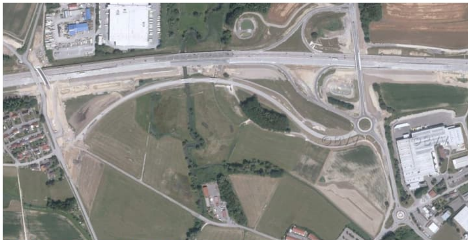
Hoher Abstimmungsaufwand mit parallel laufendem Autobahnausbau A8
