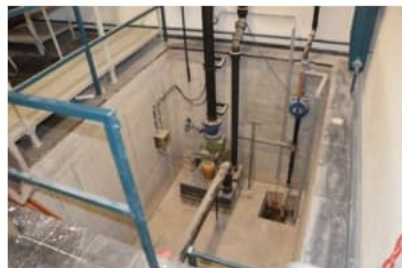
Pumpe und Leitungsführung für Schmutzwasser
