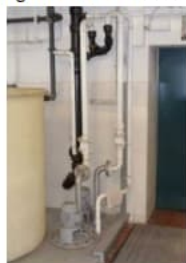
Pumpe und Leitungsführung für Schmutzwasser
