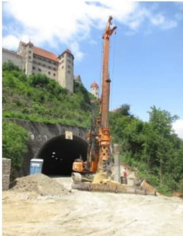
Bohrpfahlarbeiten für Lärmschutzwand
