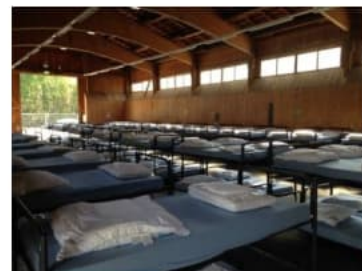
Berliner Allee, neue Innenbeleuchtung und Rauchmelder in der ehem. Salzlagerrhalle
