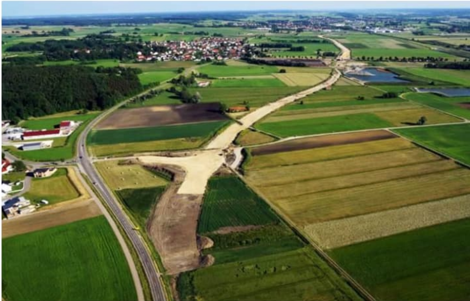
Arbeiten zur Bodenverbesserung im Überblick
