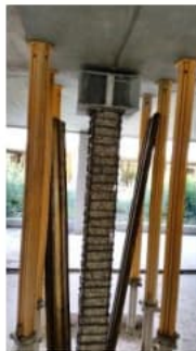
Notunterstützung während der Stützensanierung
