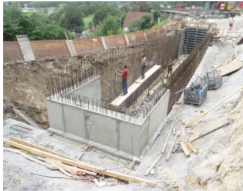
Bewehrungsarbeiten am Havariebecken
