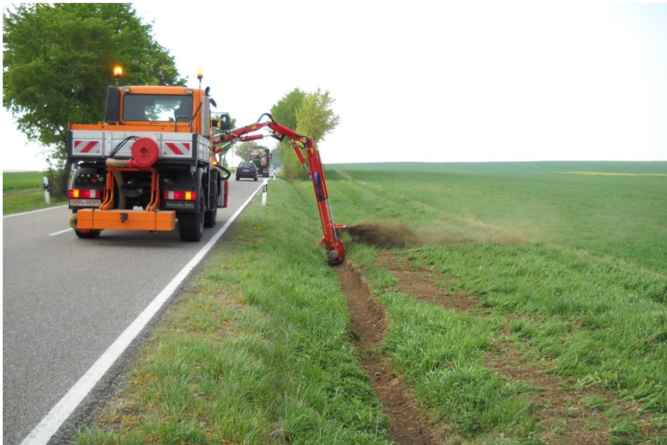
Profilieren der Entwässerungsmulde
