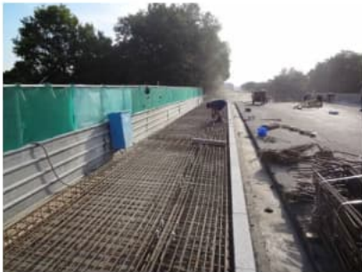
Bewehrung der neuen Kappe
