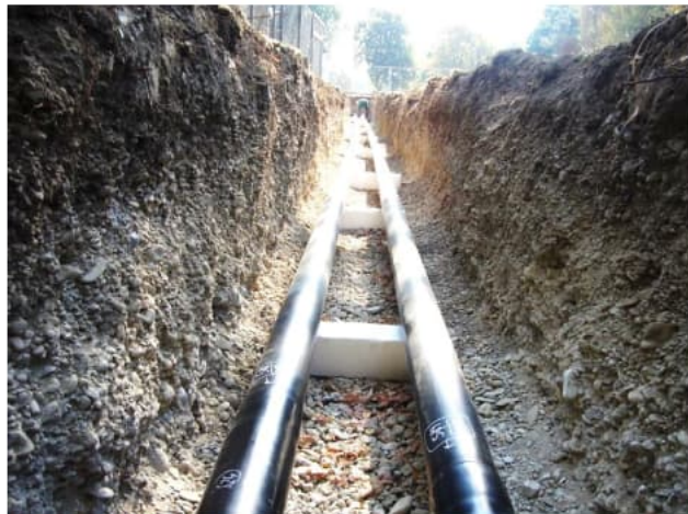
Erdverlegte Leitungsführung
