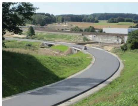
Brücken über die Zusam und den Franzosengraben
