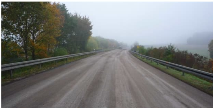
Fertige Fahrbahn, noch nicht gereinigt und ohne Markierung
