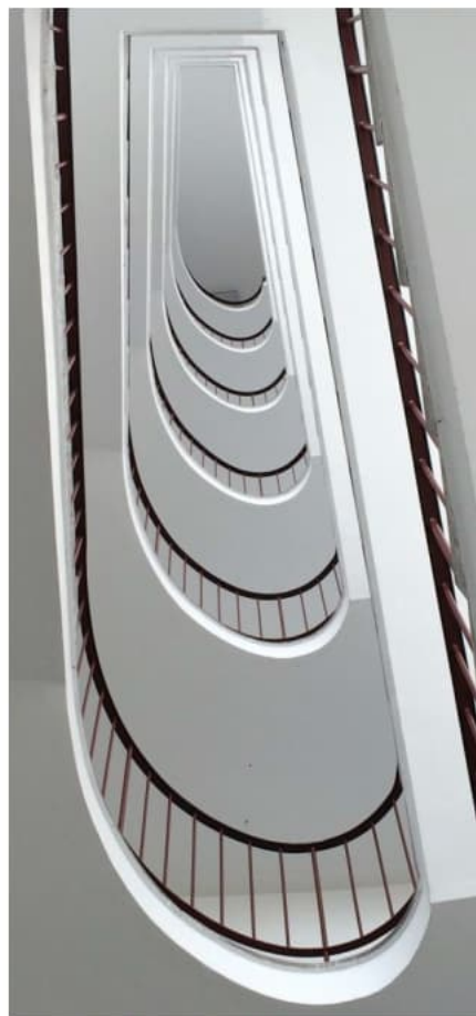
Vorhandene Treppe Geb. F2
