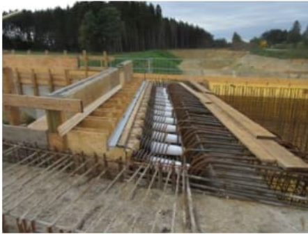
Spannglieder am Überbauende des Bauwerkes 202
