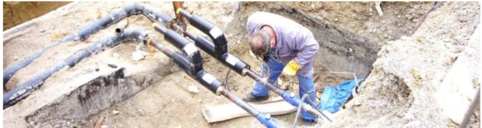
Reparaturarbeiten und Erweiterung des Bestandsnahwärmenetzes
