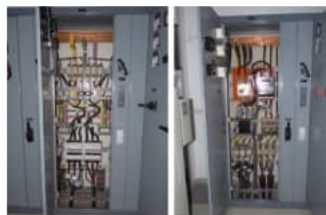
Die bisherige, über 50 Jahre alte NSHV entsprach in keiner Weise mehr den heutigen Sicherheitsvorschriften.
