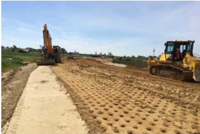
Bau des Straßendamms
