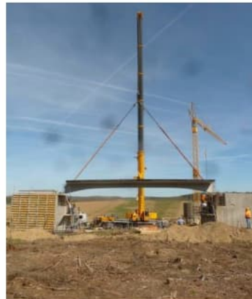
Einhub eines Fertigteiles
