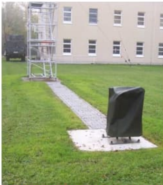
Seilwinde mit neuem Fundament u. Weg
