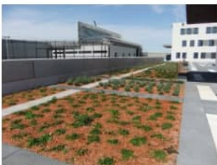
Fertiggestellte Freiflächen: im unterbauten Bereich (Dachbegrünung)
