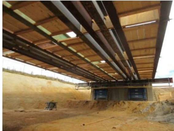
Bauwerk 203: Traggerüst für Überbau
