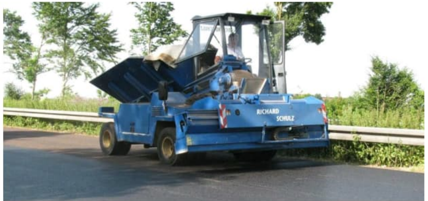
Absplitten der Fahrbahn ...
