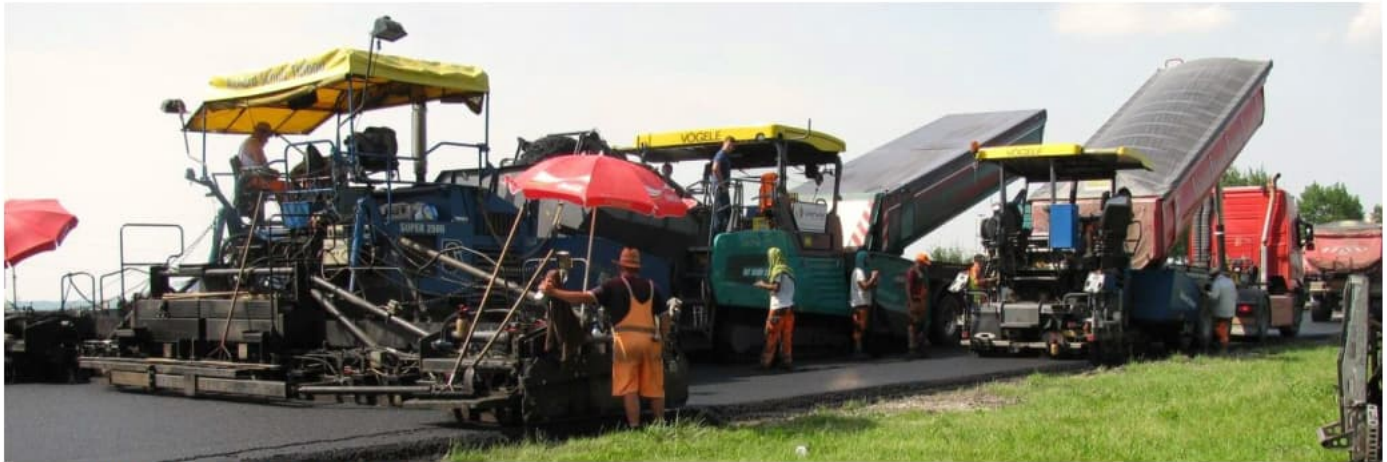
Deckeneinbau am Tag bei Temperaturen von 38 ° C
