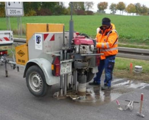
Kernbohrung zur Kontrolle der Arbeiten
