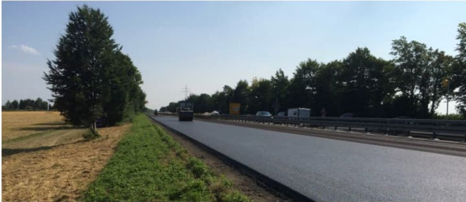
Abwalzen der Deckschicht
