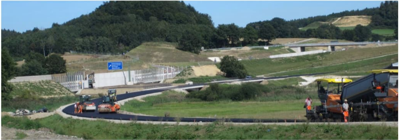
Asphalteinbau für die Ortsumfahrung parallel zur A 8
