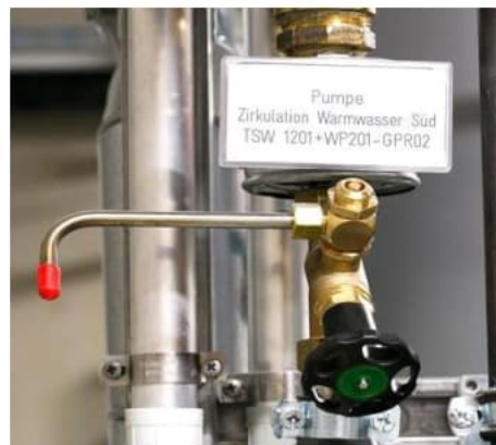
Probeentnahmehahn zur Legionellen-Überwachung
