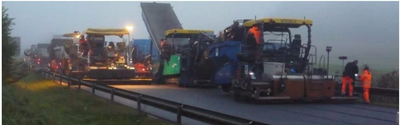
und in den frühen Morgenstunden: Asphaltteinbau in 2 Kolonnen mit Fertiger und Beschicker
