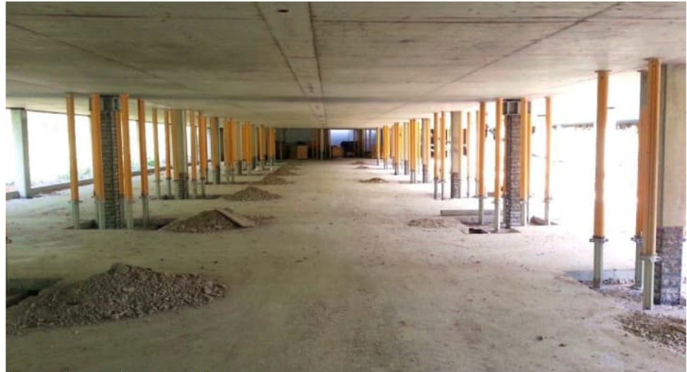
Notunterstützung während der Stützensanierung
