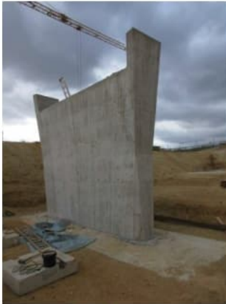
Ausgeschalter Pfeiler des Bauwerkes 203
