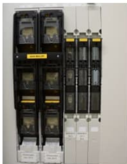
Die neuen Lasttrennschalter sind gegen Berührung gesichert
