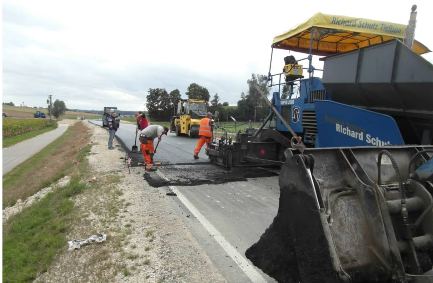
Anschluss an den 1. Bauabschnitt – hier geht's weiter mit dem 2. Bauabschnitt ...
