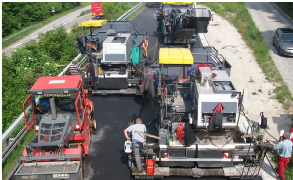
Einbaukolonne mit Fertiger und Beschicker
