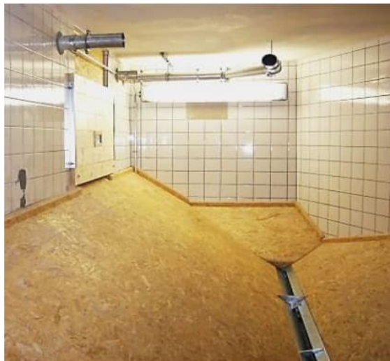
Pelletlager - Schrägboden
