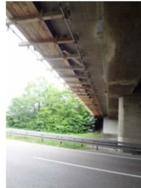
Kappengerüst über der B 2
