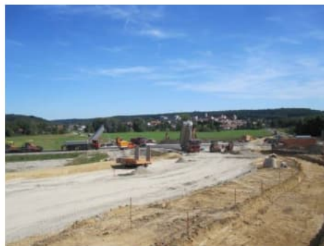
Bauarbeiten am Kreisverkehr bei Friedensdorf
