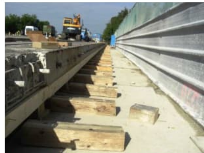
Frei gelegte Überbauauskragung mit Ankerköpfen der Querspannbewehrung
