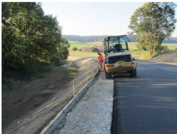
Böschungssicherung mit Stellbrettern zum Schutz vor Erosion
