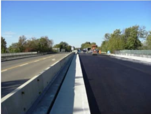
Instand gesetzter nördlicher Überbau
