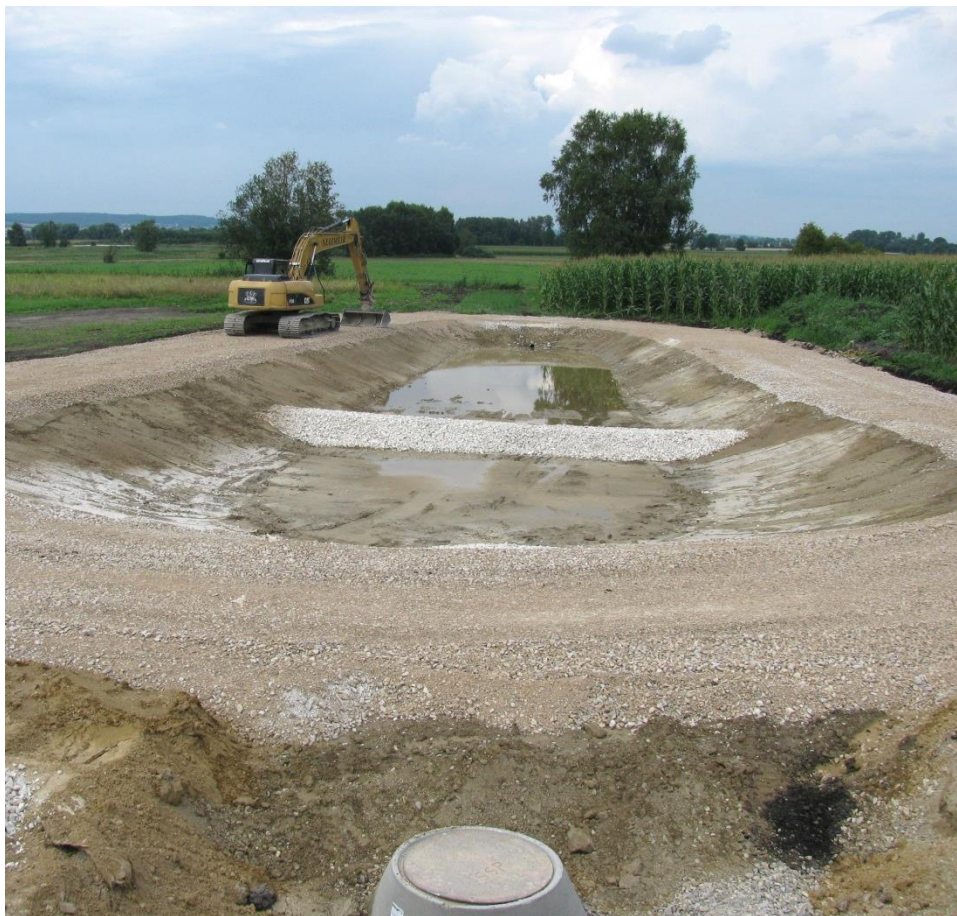
Das fast fertige Becken
