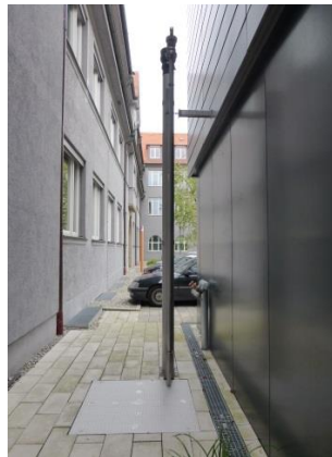
Lüftungsleitungen, Prüfschacht
