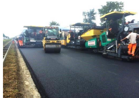
Asphalteinbau mit zwei Kolonnen
