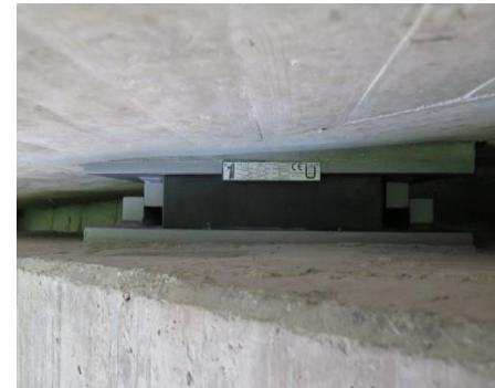
Neues querfestes Lager nach dem Einbau
