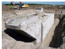
Rückbau Bunker
