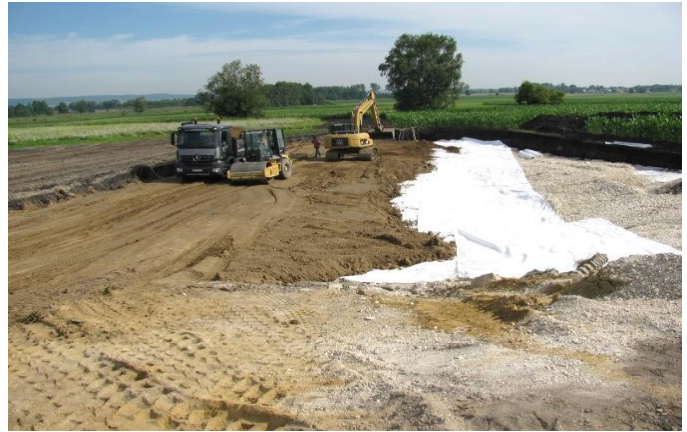
Die Entstehung eines Rückhaltebeckens in Erdbauweise im Rahmen des Ausbaus der St 2045 Pöttmes - Grimolzhausen
