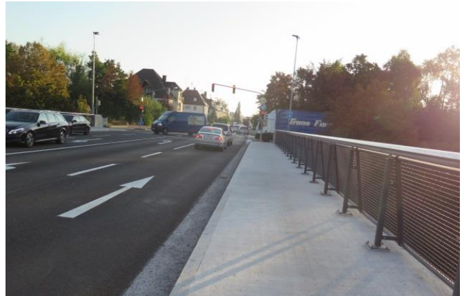
Geländergestaltung im Innerortsbereich
