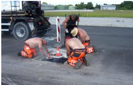
Feinarbeit! Gußasphalteinbau an den Feuern
