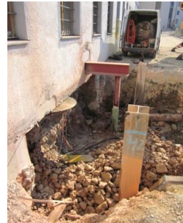
Planung und Ausführung deiner statischen Abfangungsmaßnahme an der Anschlussstelle der unterirdischen Tunnelanbindung an das bestehende Abteigebäude
