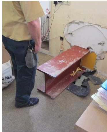
Planung und Ausführung deiner statischen Abfangungsmaßnahme an der Anschlussstelle der unterirdischen Tunnelanbindung an das bestehende Abteigebäude
