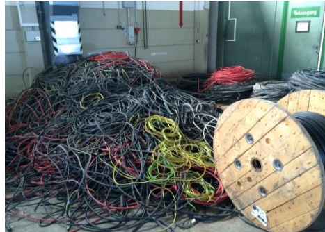
... auch die Verkabelung wird ausgetauscht...
