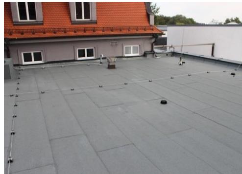
Energetische Sanierung Geb. E
