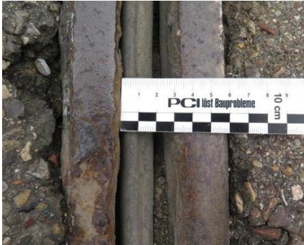
Abgängige Übergangskonstruktion
