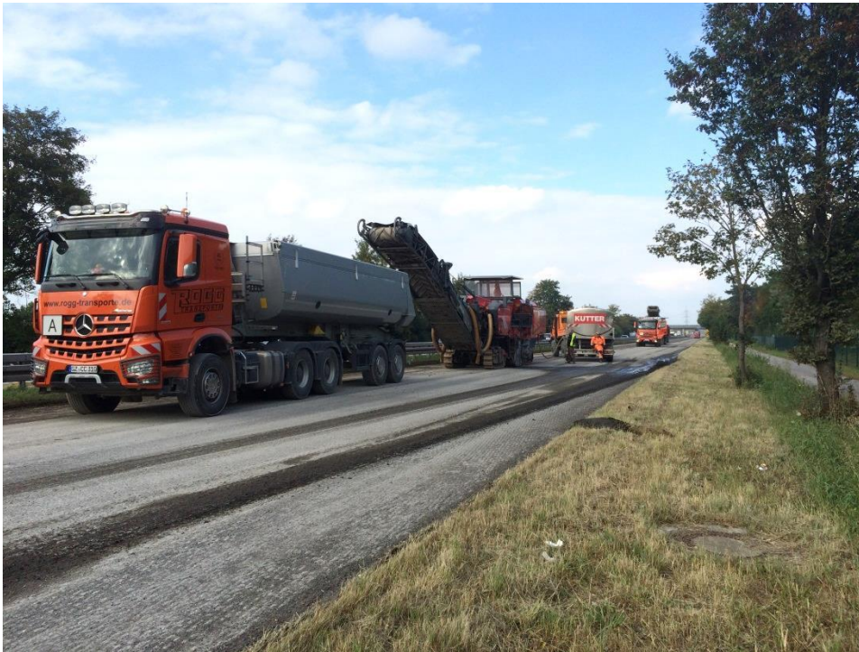
Abfräsen der alten Fahrbahndecke
