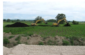
Erste Erdarbeiten am Erdbecken
