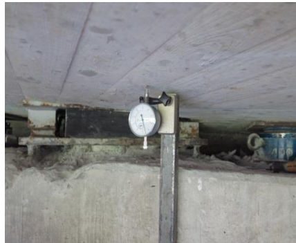
Anhebung Brückenüberbau mit hydraulischen Pressen
