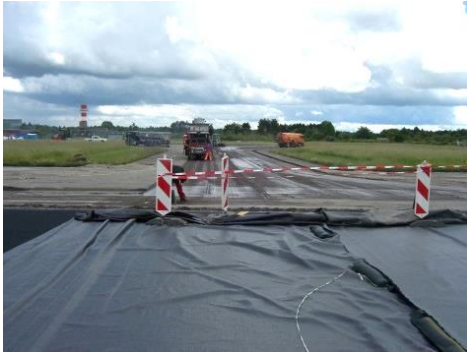
In unmittelbarer Nähe zur Start- und Landebahn wird der Rollweg Ost partiell instandgesetzt:
