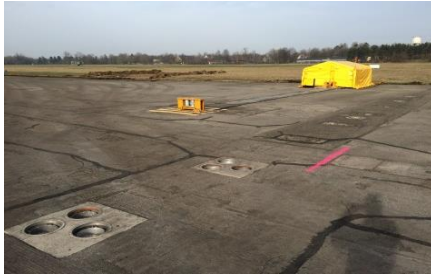
Die alte Befehung ist abgebaut...
