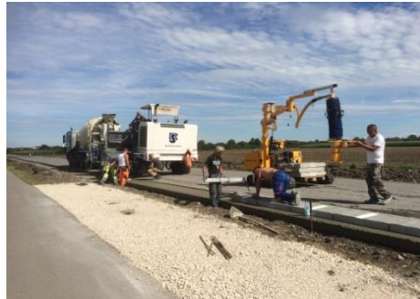
Setzen der Bankettplatten ...
