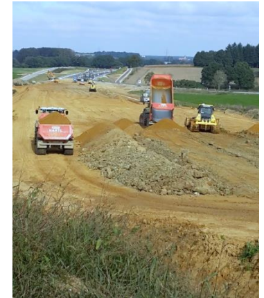
Erdauftrag am Gallenbacher Berg
