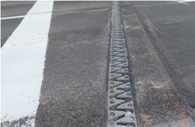
Neue, lärmgeminderte Übergangskonstruktion
