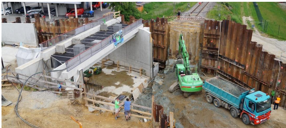
Brücken- und Trogteil seitlich neben der Bahnachse – vor dem Verschieben
