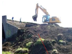
Rückbau Flugzeug-Shelter
