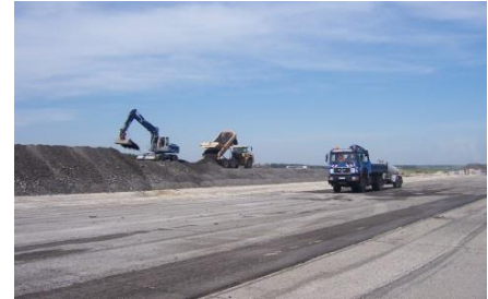
Ca. 30.000 m 3 Fräsgut der 30 m breiten Schultern
