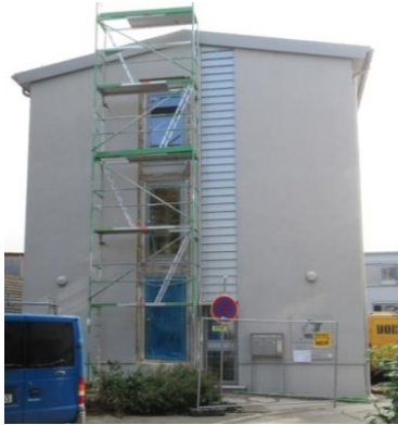
Herstellung der Ausgänge zur Fluchttreppe
