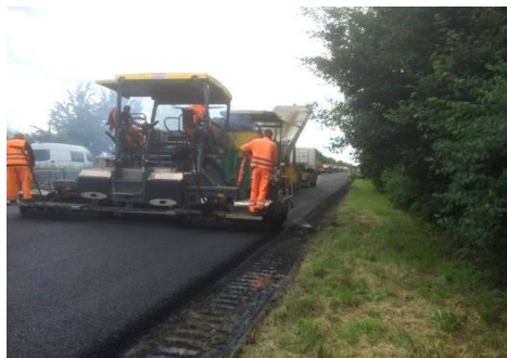
Asphalteinbau mit Fertiger und Beschicker
