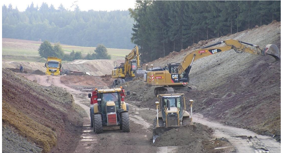
Abtrag im Einschnittsbereich mit unterschiedlicher Bodenbeschaffenheit
