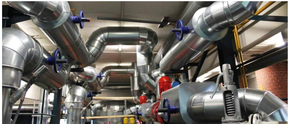
Anbindung der bestehenden Kesselanlagen
