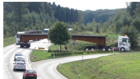
Stahlträger für Brückenüberbau
