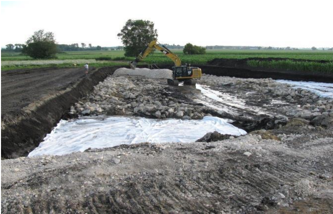
Die Entstehung eines Rückhaltebeckens in Erdbauweise im Rahmen des Ausbaus der St 2045 Pöttmes - Grimolzhausen
