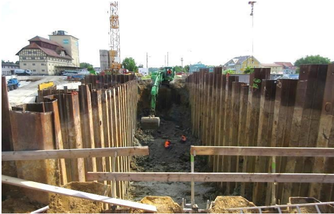
Aushub zwischen den beiden Querschotts im Bereich der Bahntrasse
