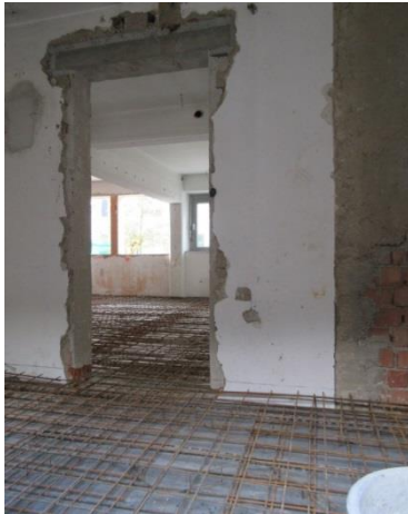
Einbau Geschossdecke ehem. Garagen
