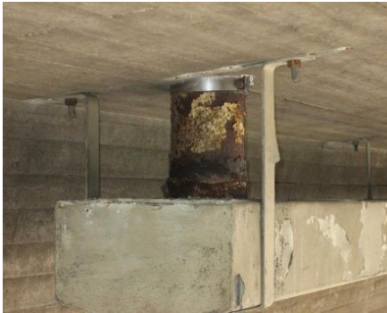
Alte Kastenrinne mit verrosteten Einläufen
