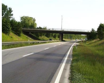
Ansicht des Bauwerkes von der B 2
