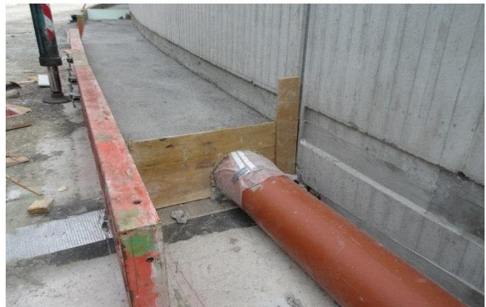
Betonieren des Notgehwegs mit Fuge und Rohrleitung
