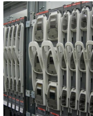
Sicherungslasttrennschalter
