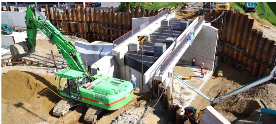
Nach dem Verschieben des gesamten Brücken- und Trogteils
