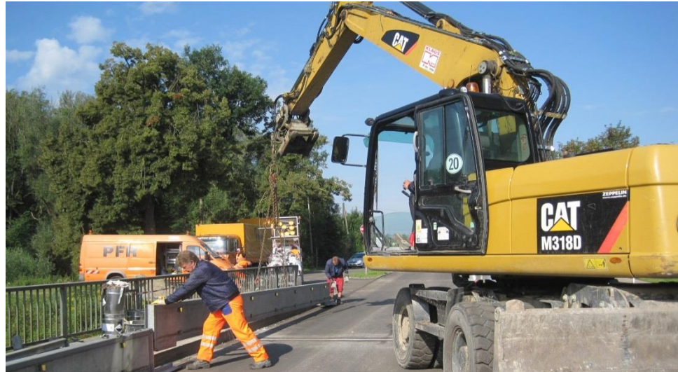
Wiedereinbau Betonschutzwand auf Lechbrücke
