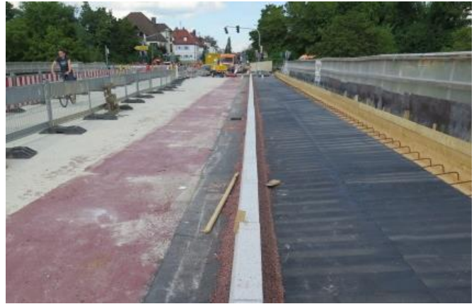
Abgedichteter Überbau nach dem Setzen der Bordsteine
