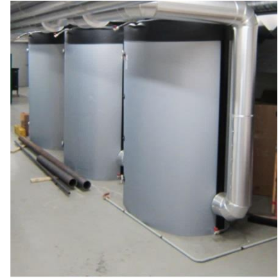
Heizwasser-Pufferspeicher 3x2000l
