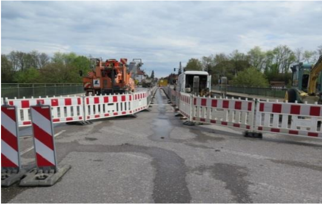
Bauen unter Aufrechterhaltung der Fußgänger- und Radfahrerströme während der gesamten Bauzeit
