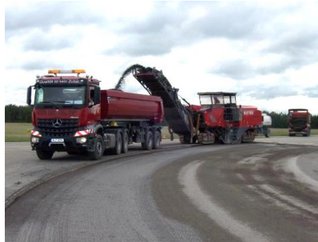
Der Asphalt wird gefräst, ...
