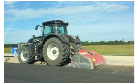
... 15 m neu befestigte Schulter in Schotterrasen
