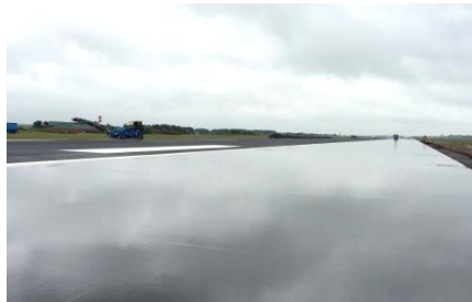
15 m neu befestigte Schulter in Asphalt und ...
