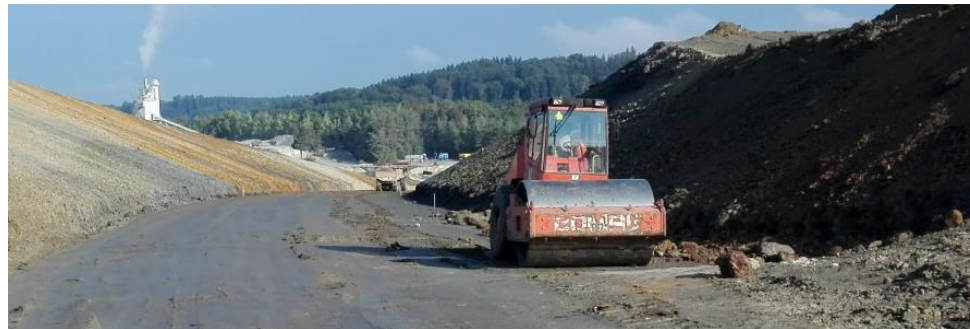
Verdichtung des Erdplanums
