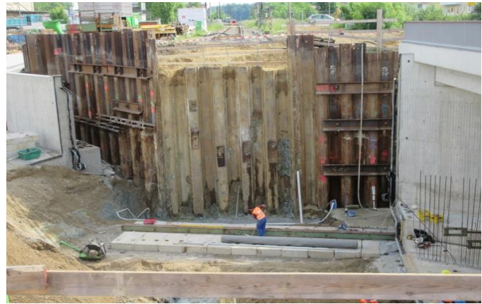
Herrichten der Verschubbahn
