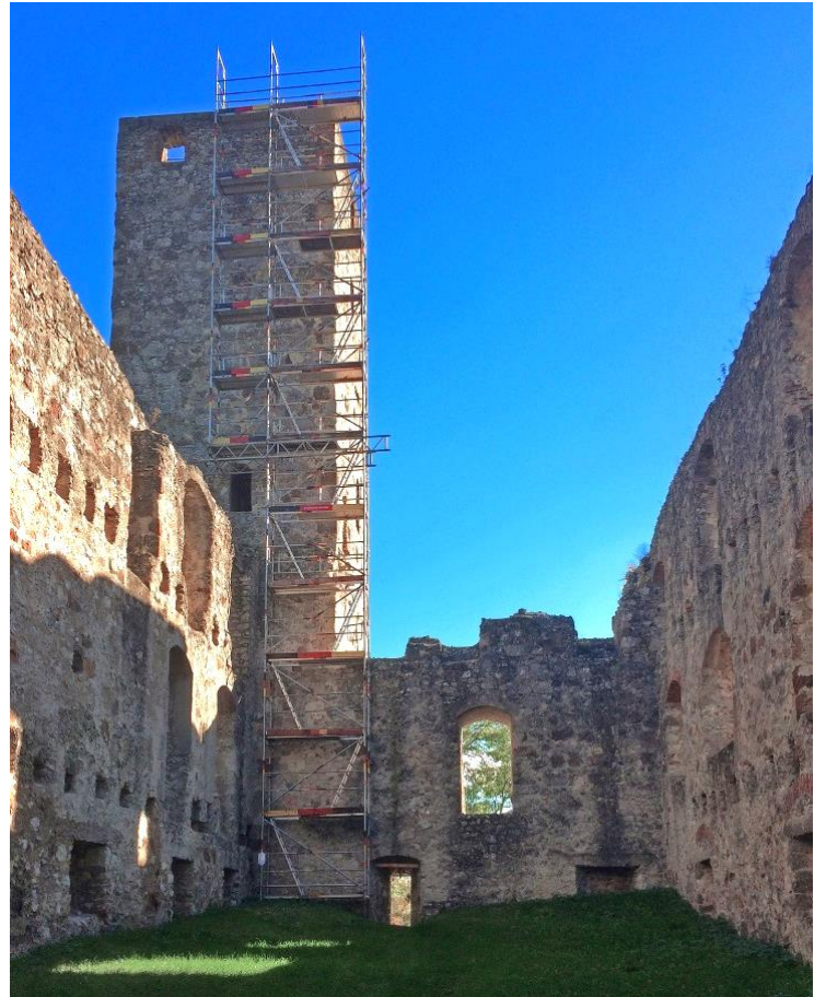
Sanierungsarbeiten am Burgfried
