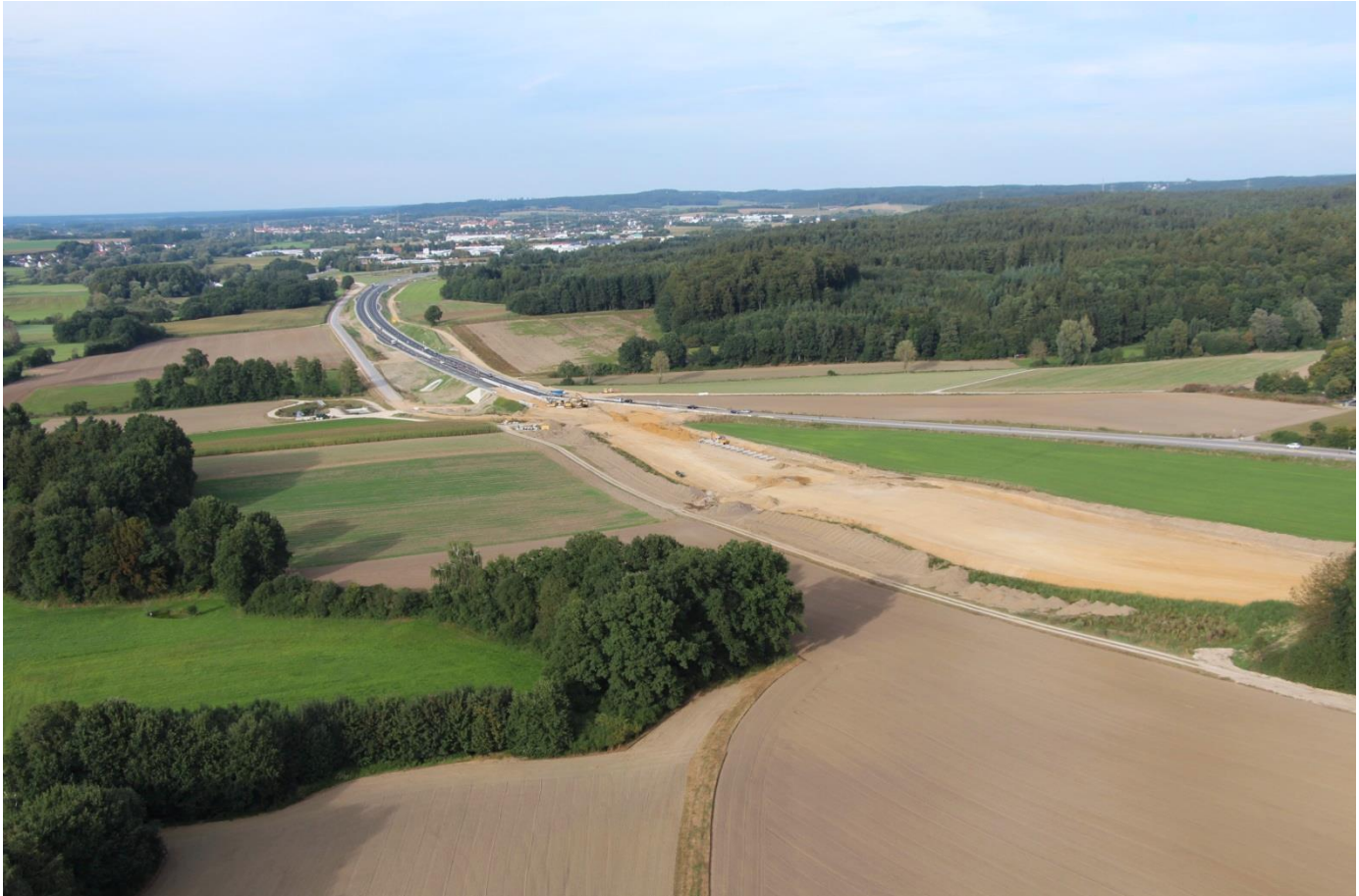
Luftbild der Baumaßnahme B 300 Dasing – Aichach im September 2016
