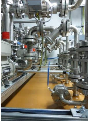
Pumpen, Kompensatoren, Schmutzfänger, Detonationssicherungen
