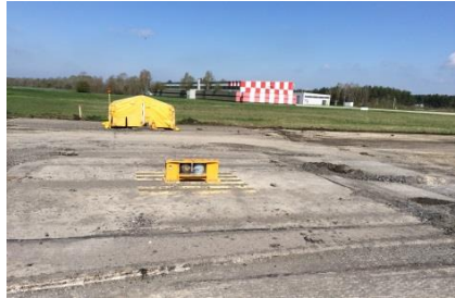
... jetzt kann der Asphalt gefräst werden.
