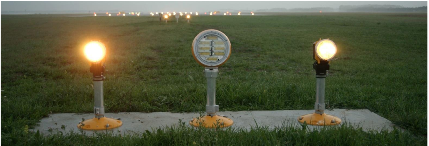
Anflugfeuer Mittellinie mit Mittellinienblitz
