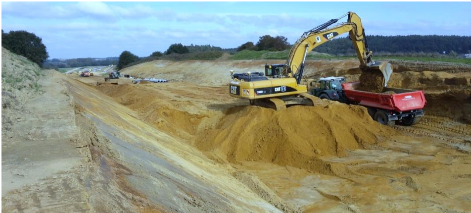
Erdauftrag am Gallenbacher Berg
