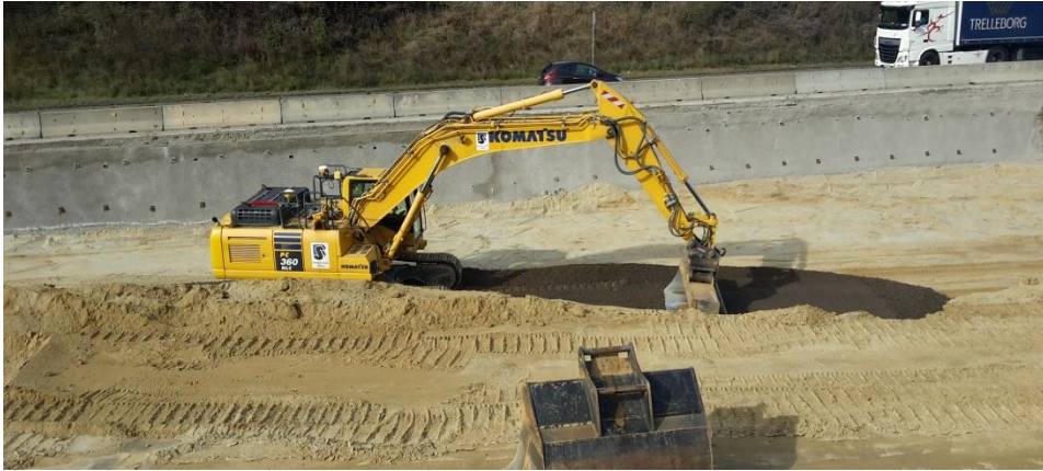
Rückverankerte Spritzbetonwand mit zwei Ankerlagen zur Sicherung des vorhandenen Verkehrswegs
