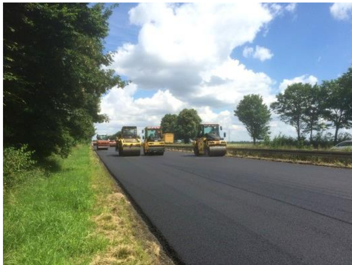
Sechs Walzen im Einsatz
