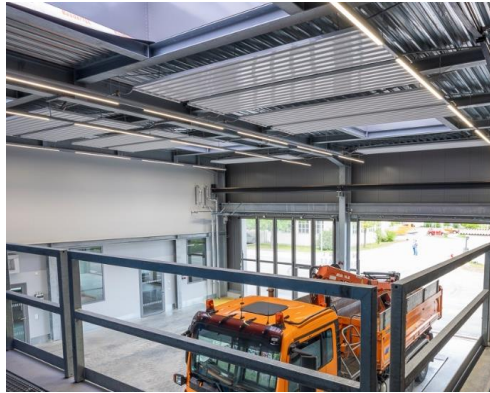
Deckenstrahlplatten
