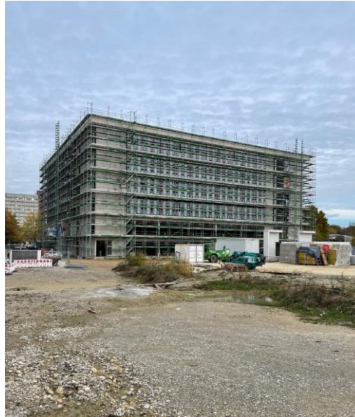
Blick auf die Südfassade
