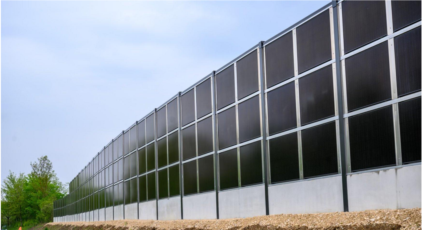
Straßenansicht der neuen Lärmschutzwand mit integrierten PV-Elementen in Blickrichtung Westen am 08.05.2023 (Presstetermin mit Ministerpräsident Markus Söder)
