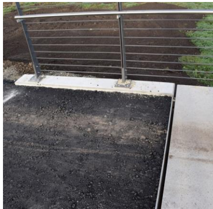
Geländer am Brückende
