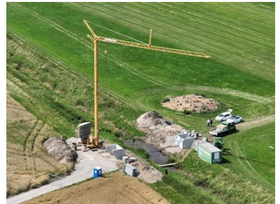
Baufeld am Schwarzbach mit fertiggestellten Wiedergelagern
