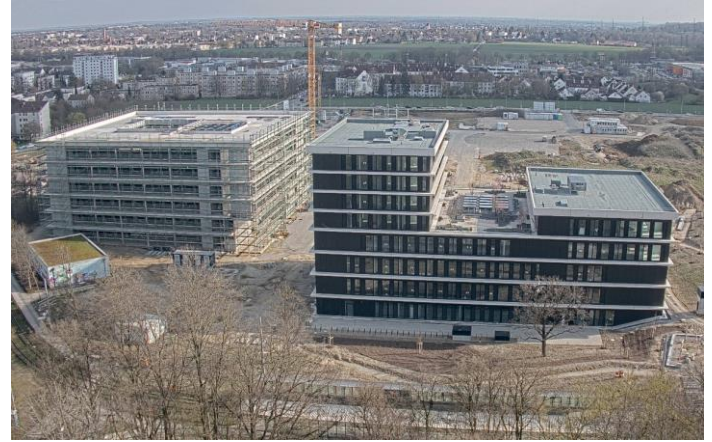
Baustelle im April
