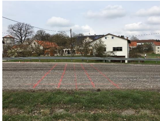
Neuinstallation der Dauerzählstelle auf der B300 bei Oberzell
