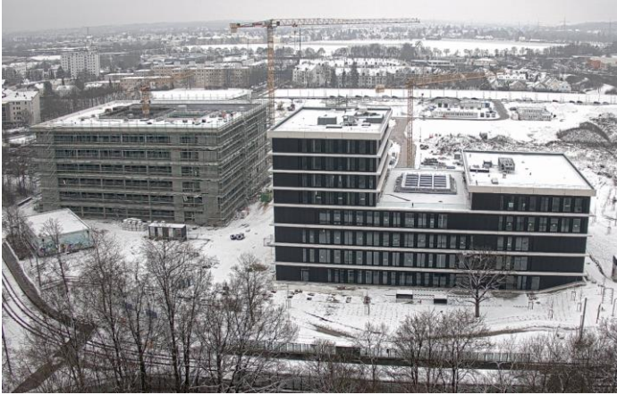
Baustelle im Januar
