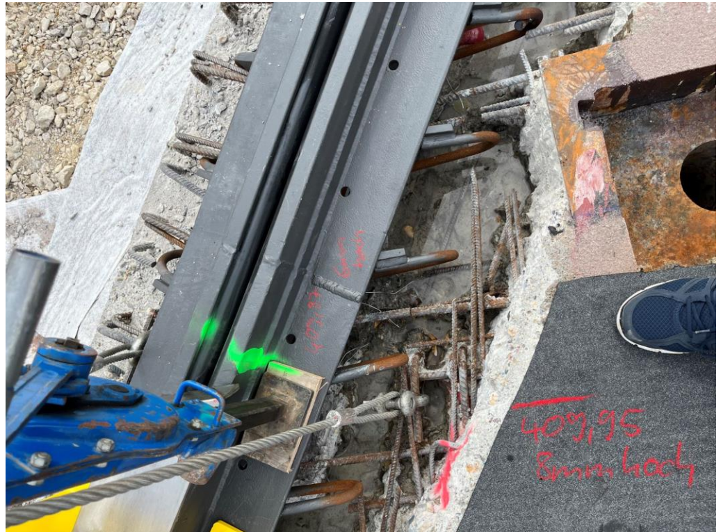
Einbau der neuen Übergangskonstruktion (Dehnfuge mit Dichtprofil) im Übergangsbereich Strecke / Brücken
