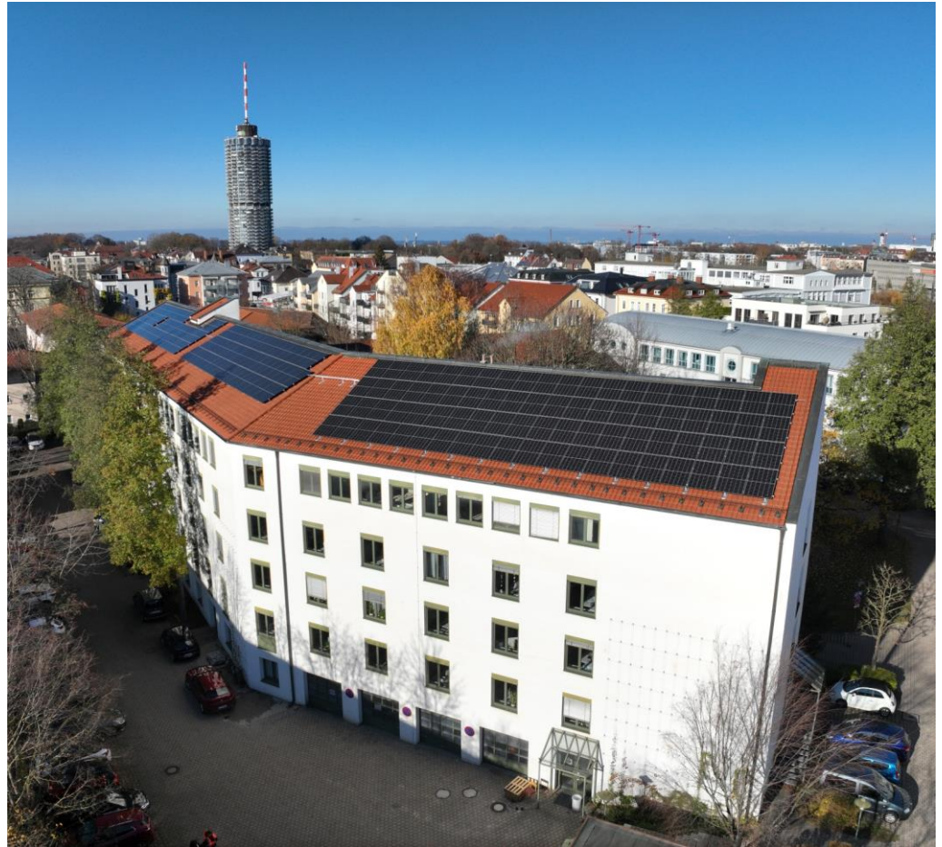
Neue Photovoltaikanlage auf dem Dach des Gewerbeaufsichtsamts Augsburg
