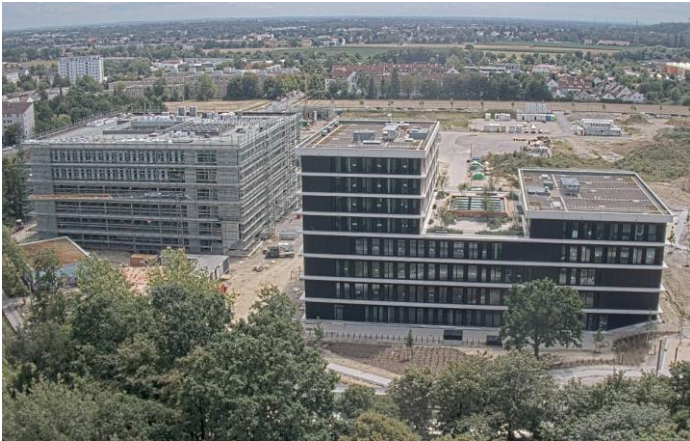
Baustelle im Juli
