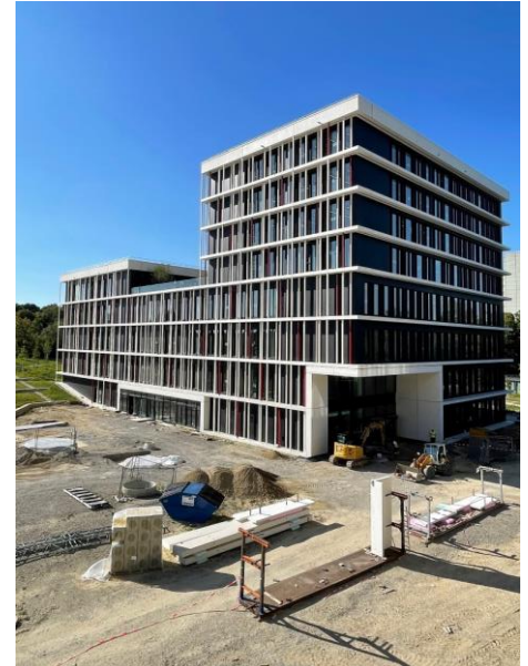
Blick auf die Süd- und Ostfassade
