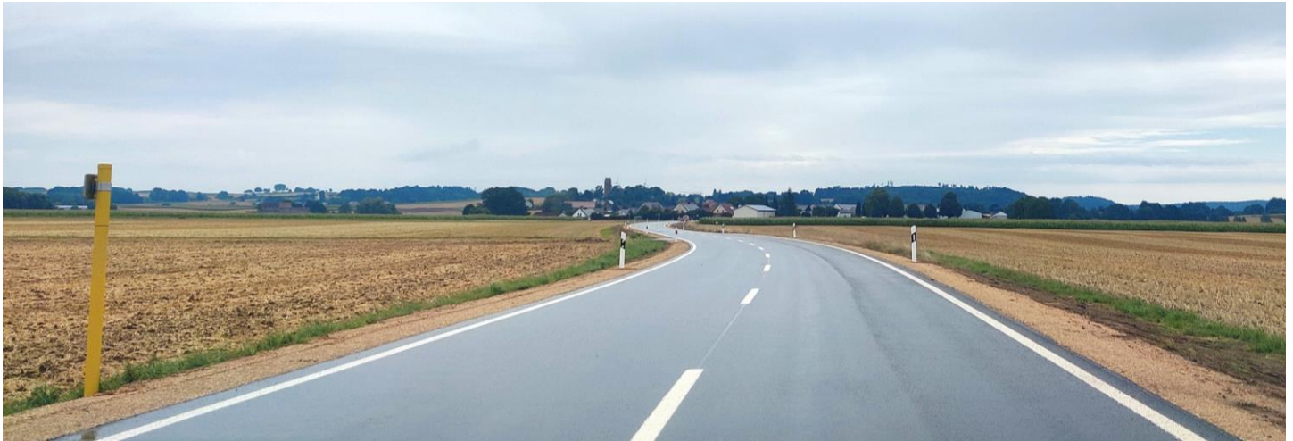
St 2027 Ausbau Rain - Überacker
