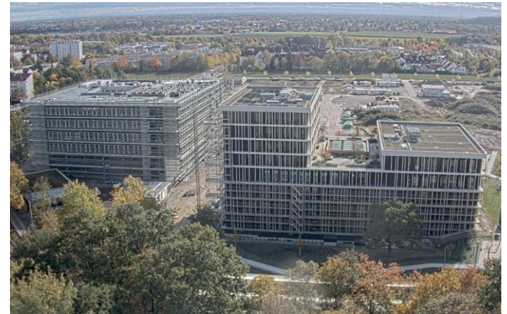
Baustelle im Oktober
