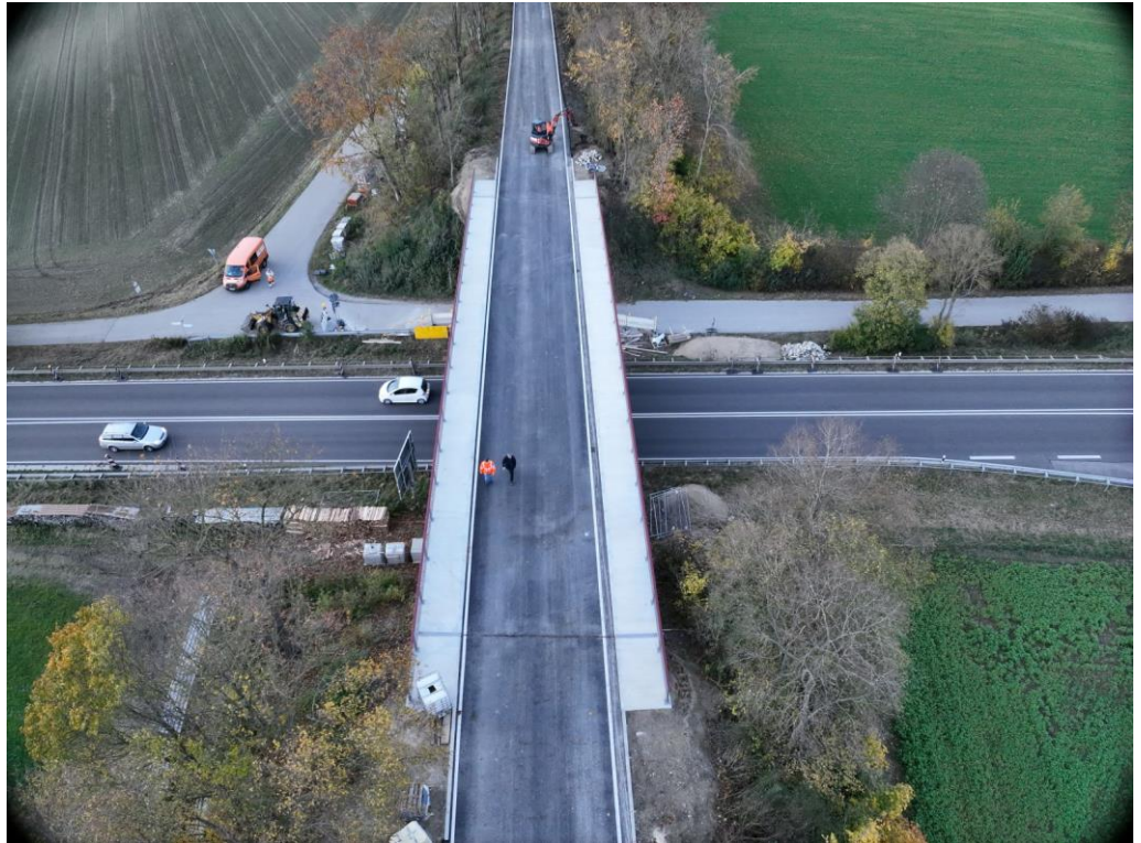
Überführung vor Abschluss der Instandsetzungsarbeiten in Blickrichtung Nordwest (B300 unterhalb)
