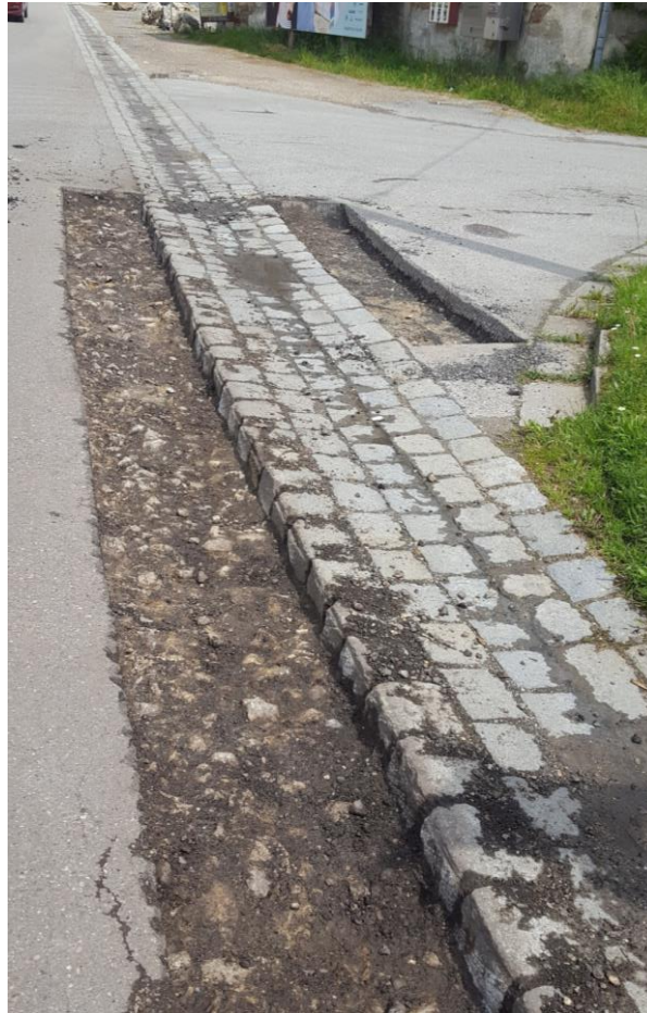
Sanierung einer Pflasterzeile
