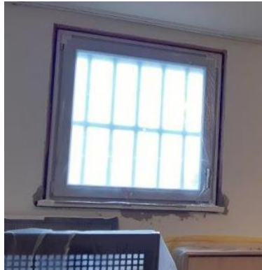
Erneutes Fenster im Bauzustand
