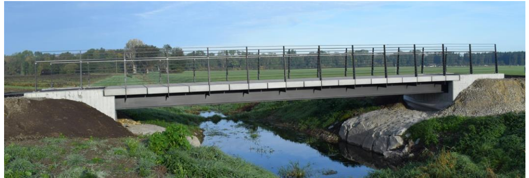
Seitenansicht am Abnahmetag 23.10.2023
