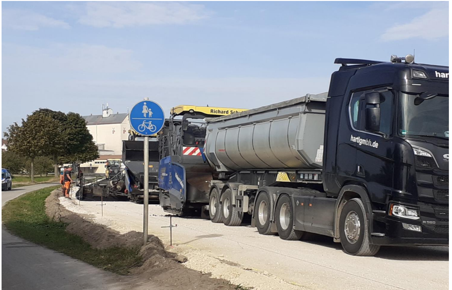
Einbau der Tragschicht der Fahrbahn
