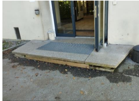
Barrierefreier Umbau Eingangsbereich EG Nord Geb. 1
