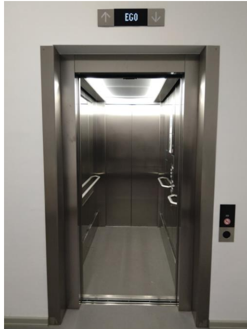
Neuer Aufzug im Westflügel des Gerichtsgebäudes
