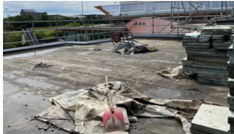
Rückbau Umkehrdach
