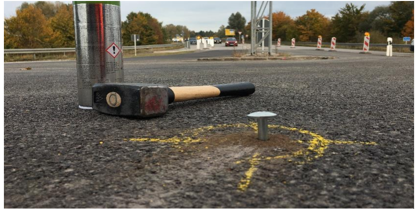
Stationsnagel zur Markierung der Station auf der Fahrbahn
