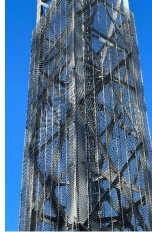
Sicherheitsgitter zur Besteigung
