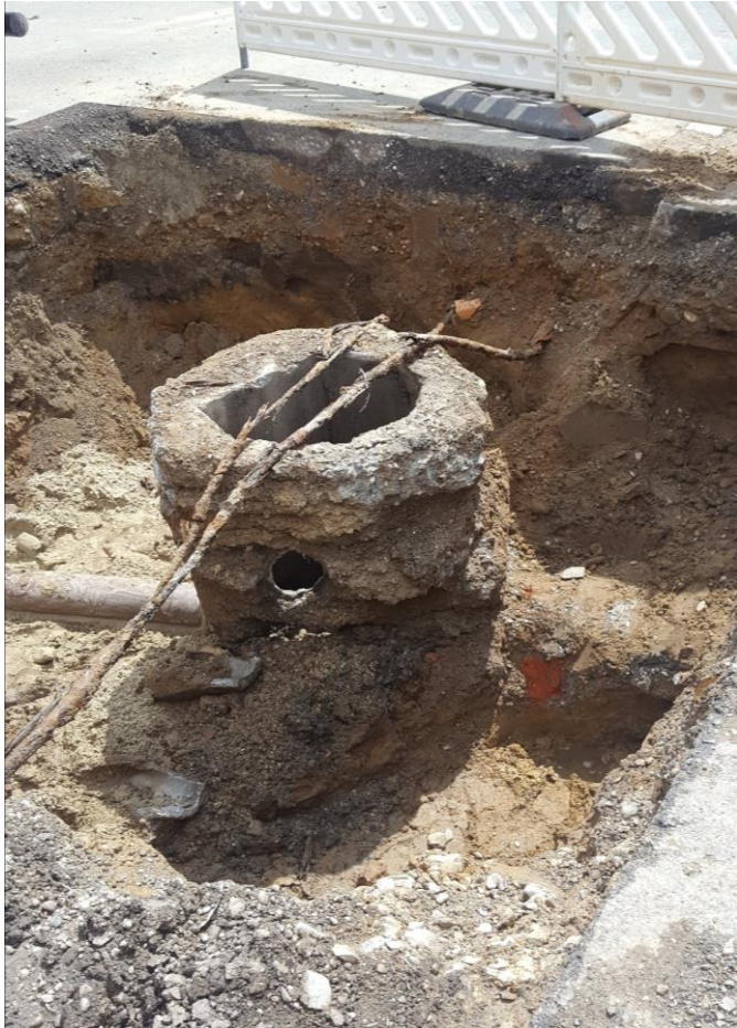
Freigelegter Schacht im Bestand
