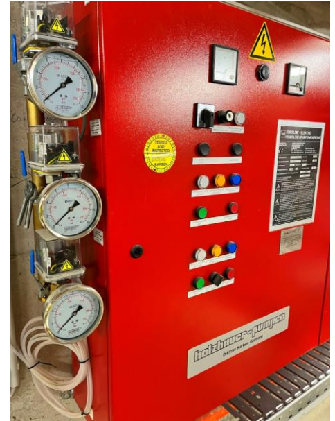
Schaltschrank für die Sprinkler-Anlage
