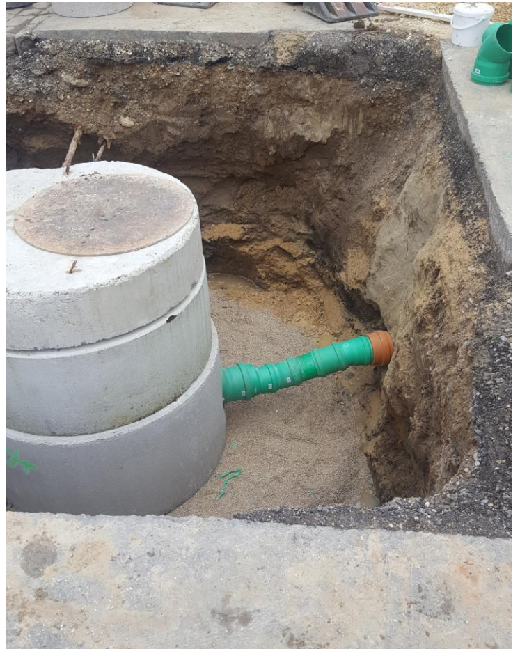
Erneuerter Schacht mit neuer Anschlussleitung
