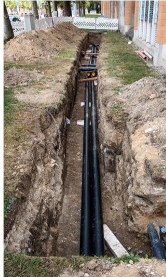
Verlegung der neuen Fernwärmeleitungen durch die SWA
