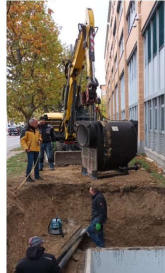
Ausbringung der alten Gaskessel
