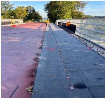
Versiegelung, Abdichtung und Betonanker
