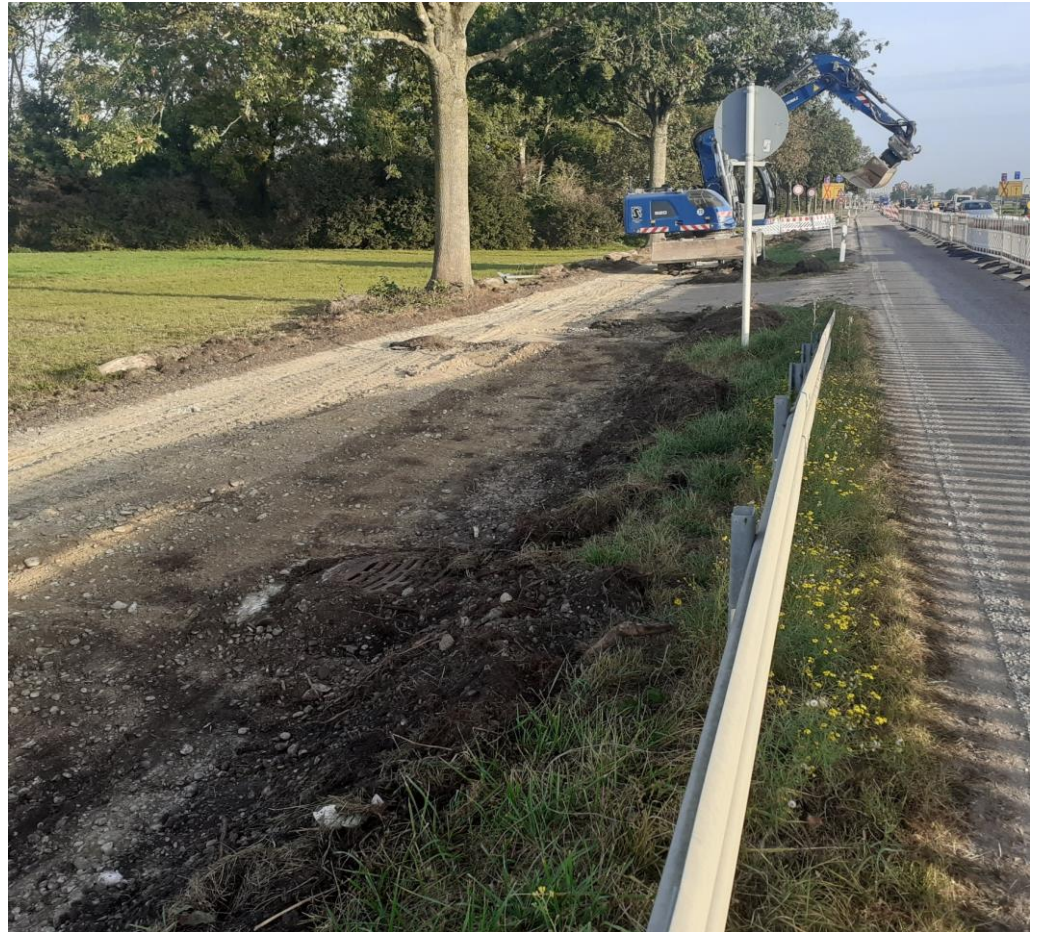
Sanierung des Radweges am Kaisersee
