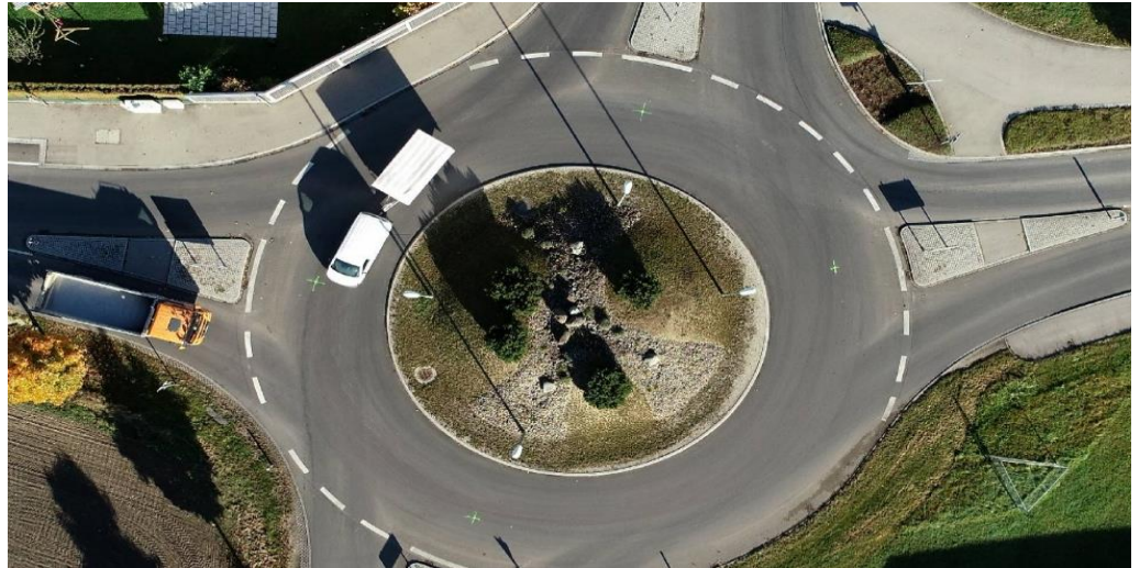
Einmessen der Nullpunkte nach Deckeneinbau am Kreisverkehr
