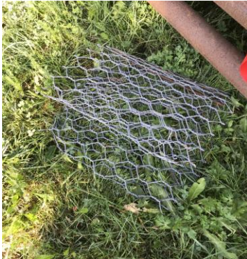
Vertikaler Biberschutzwahl zwischen Neubau- strecke und Fischbachmähergraben
