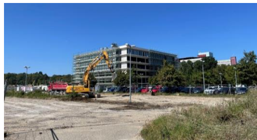
Vorbereitende Arbeiten Parkplatz Ost
