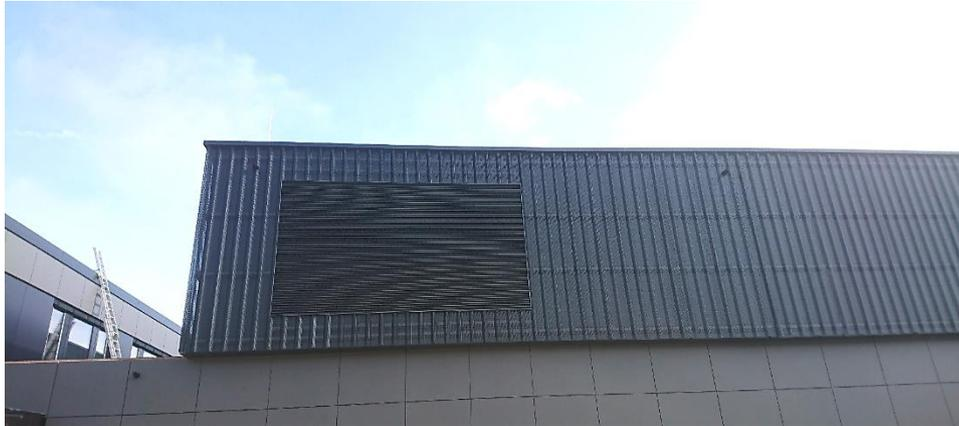
Wetterschutzgitter für die Außenluftansaugung und den Fortluftausblas in der Fassade des Technikgeschosses
