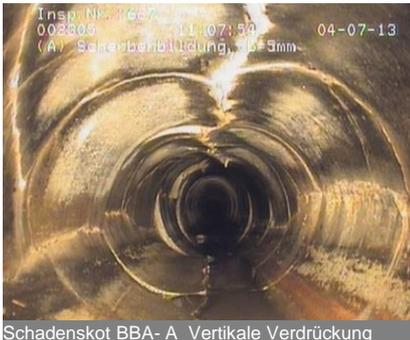
Schadenskot BBA- A Vertikale Verdrückung
