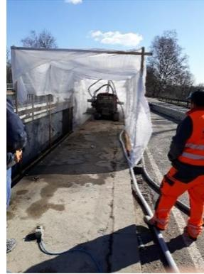
Fräsroboter für Kappenrückbau der Lechbrücke
