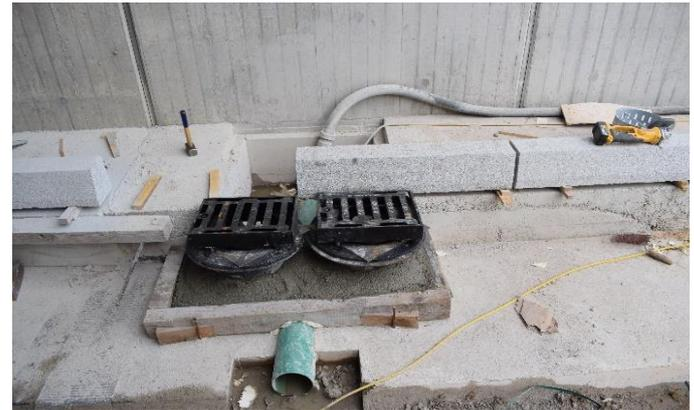
Einbau der Abläufe und Bordsteine am Tiefpunkt der Grundwasserwanne
