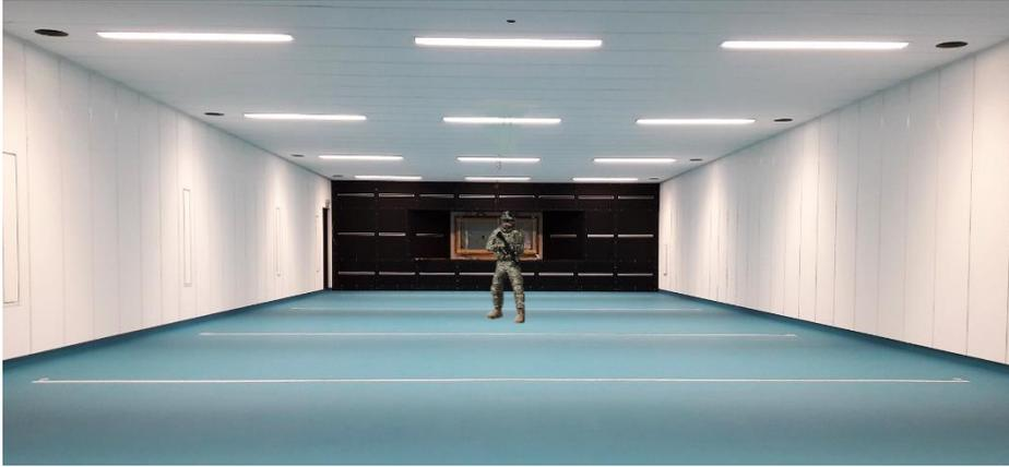
Schießbahn mit Luftgitterrückwand (schwarz) zur Zuluftbringung hinter dem Schützen, um beim Schießvorgang entstehende Schadstoffe über eine Kolbenstromlüftung abzuführen
