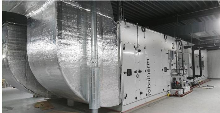
Eine von drei Lüftungsanlagen im darüberliegenden Technikgeschoss mit einem Volumenstrom von 25.000 m<sup>3</sup>/h pro Schießbahn
