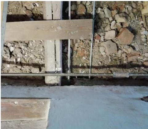
Anschluss der Quer- und Längszugstangen an die Turmwände
