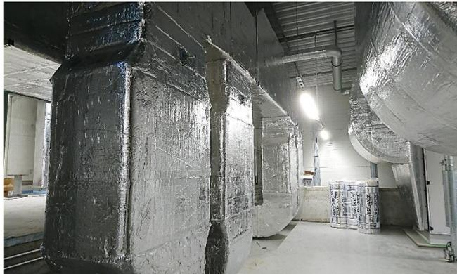
Großdimensionierte Lüftungskanäle beispielhaft zur Luftführung und -verteilung im Technikgeschoss
