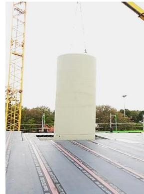
Einbringung Pufferspeicher zur Bereitstellung der Wärmeleistung
