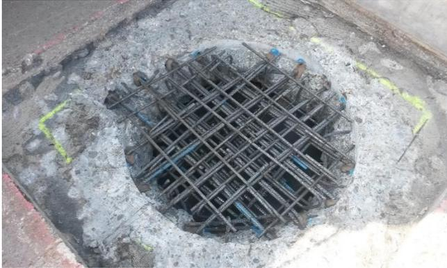
Bewehrung für das Schließen einer Öffnung im Fahrbahnbereich des Überbaus der Lechkanalbrücke
