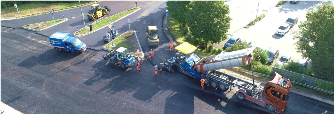
Asphaltinbau im Kreuzungsbereich in der untergeordneten Straße – kurz darauf kann die Hauptfahrbahn durchgängig asphaltiert werden
