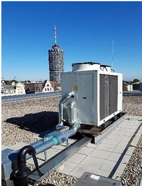
Kältemaschine mit freier Kühlung
