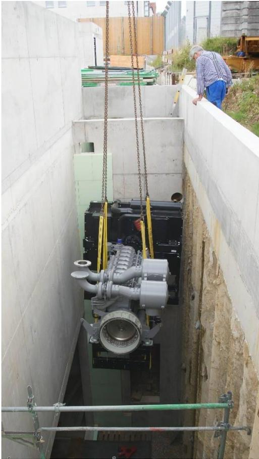
Der Dieselmotor wird per Autokran in das Gebäude gehoben
