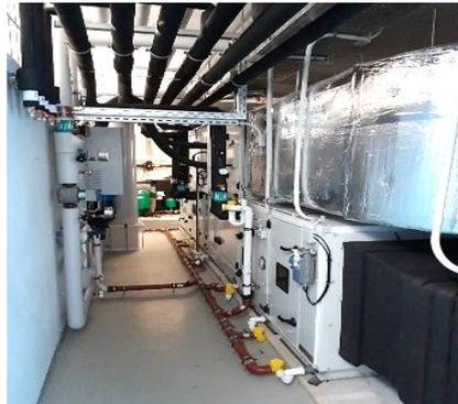
Getrennte Zu- und Abluftgeräte mit einem Kreislaufverbundsystem zur Wärmerückgewinnung
