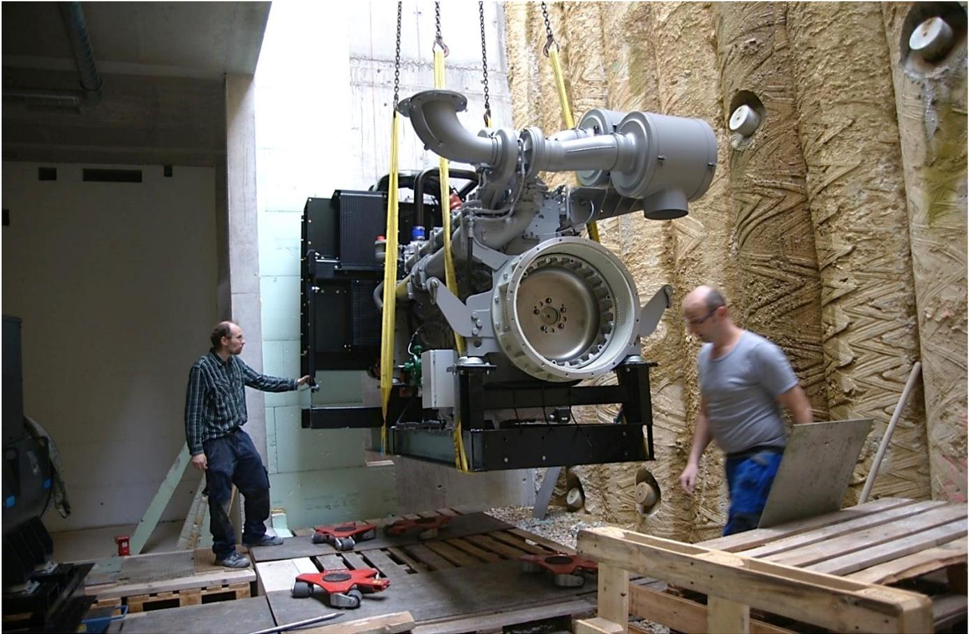
Der Dieselmotor wird im Untergeschoss des Versorgungszentrums abgesetzt
