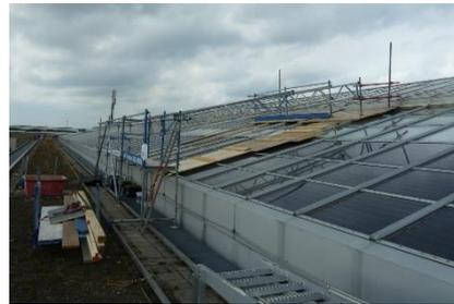
Untersuchung der Dichtebenen des Glasdaches
