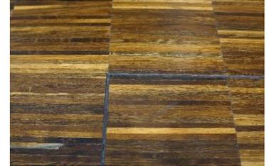
Im Boden eingelassene Induktionsschleife
