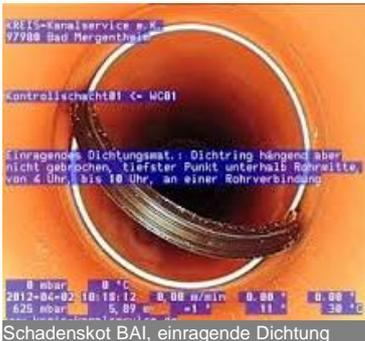
Schadenskot BAI, einragende Dichtung
