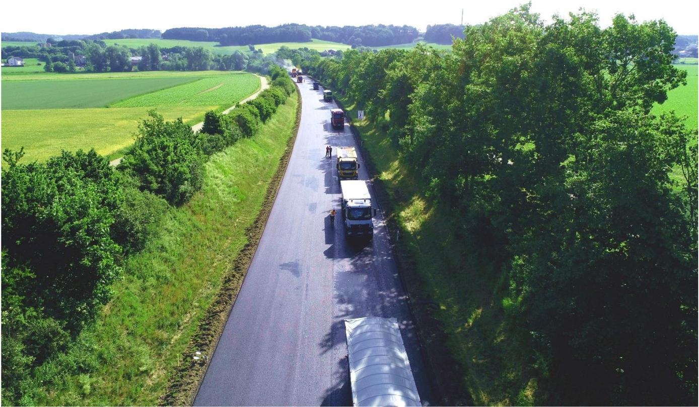
Lastkraftwagen mit Asphaltmischgut in abgedeckten Thermomulden stehen bereit – der Materialnachschub ist gewährleistet
