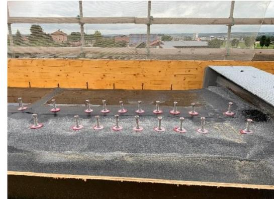
Ankerreihen für die Befestigung der Kappe auf dem Überbau
