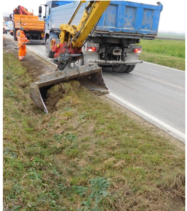
Bankettschälarbeiten, St 2221 zwischen Möttingen und Ziswingen
