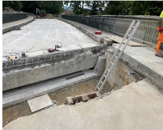
Abbrucharbeiten am Ende des Überbaues
