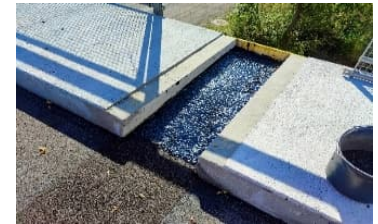
Asphaltübergang im Bau
