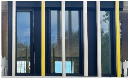
Musterfassade mit Keramikstäben in gelb und beige
