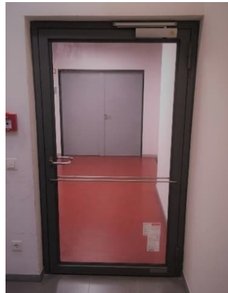
Erneuerung Brandschutzverglasungen
