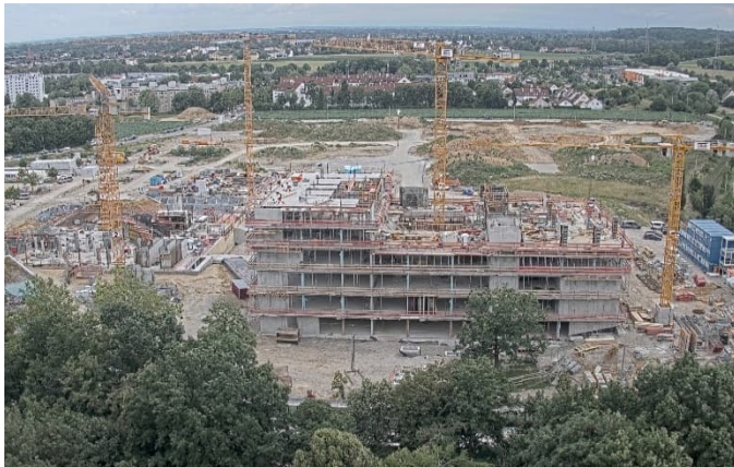
Baustelle im Juli
