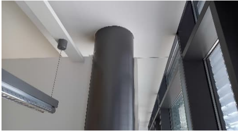
Carrels Bibliothek H-Bau
