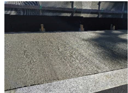
Fertig gestellte Kappe mit Besenstrich
