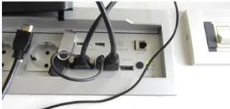
Beispiel für den Einbau der Medientechnikanschlüsse in bauseits gestellte Tische
