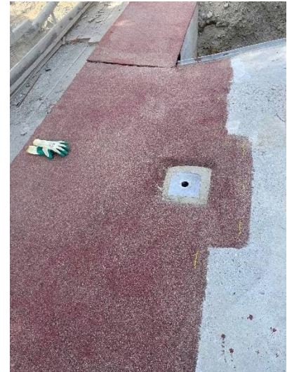
Tropftülle im Überbau
