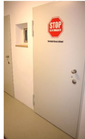
Einfassungen der Öffnungen mit minimierten Kanten und bruchsicheren Scheiben
