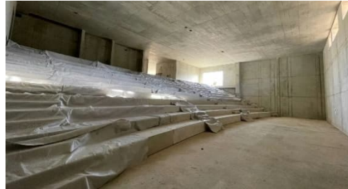
Hörsaal im Rohbau
