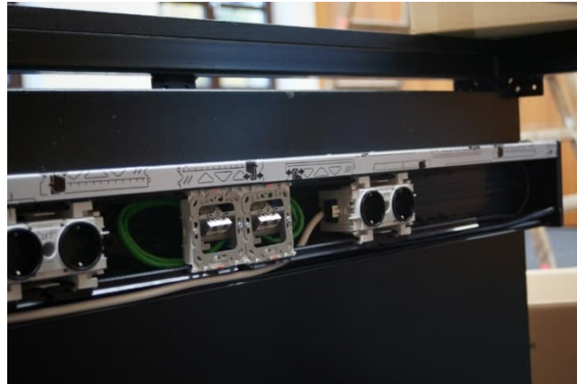
Weitere Sitzungssäle in Augsburg werden bereits umgerüstet
