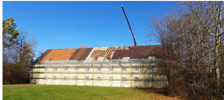
Unterkunftsgebäude LFK: Dachsanierung
