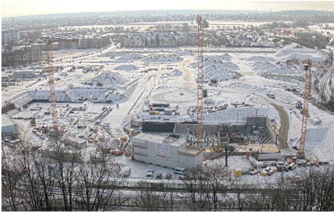
Baustelle im Januar
