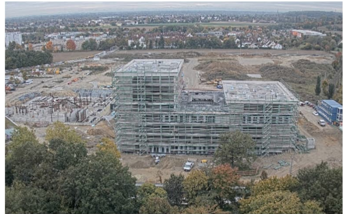
Baustelle im Oktober
