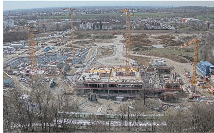
Baustelle im April
