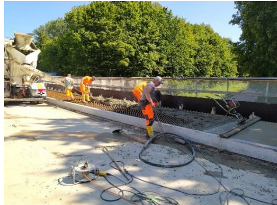
Betonage der verbreiterten südlichen Kappe am BW 7532/522
