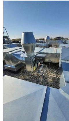
Sonderabluft auf dem Dach
