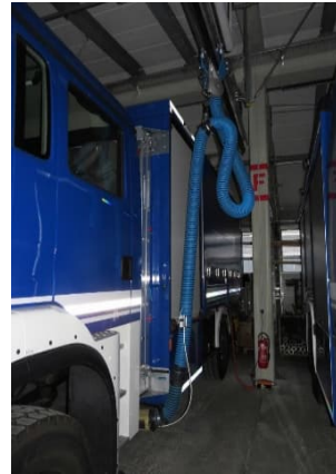
Saugeinheit am Abgasrohr MLW
