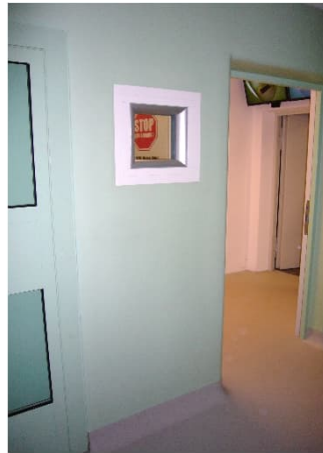
Einfassungen der Öffnungen mit minimierten Kanten und bruchsicheren Scheiben
